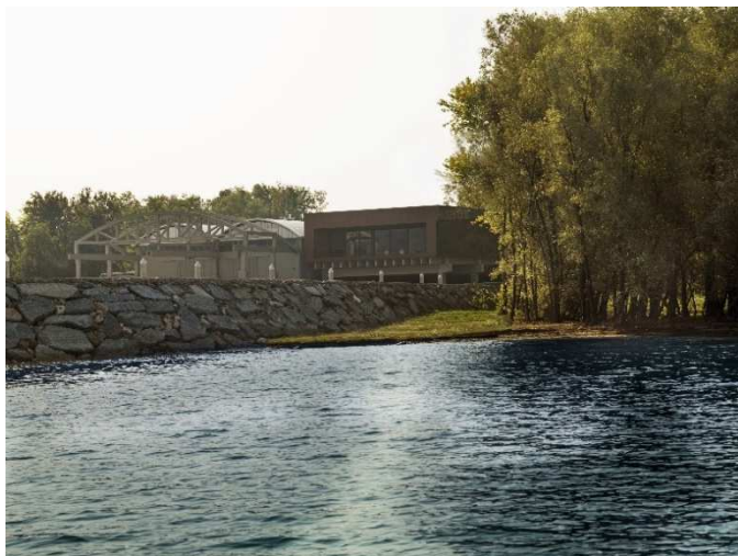
Figura 2 – Stato attuale scogliera Punto di ripresa 1
