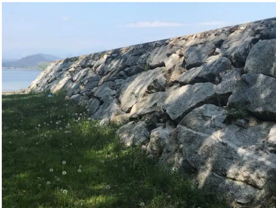
Figura 18 – Stato di fatto
