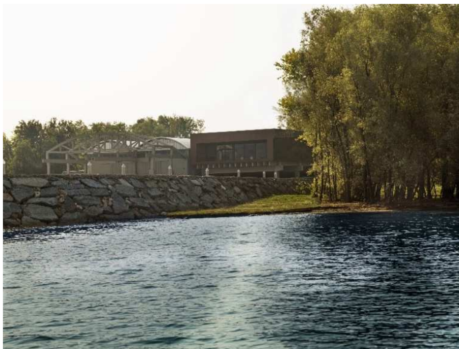
Figura 16 – Stato di fatto
