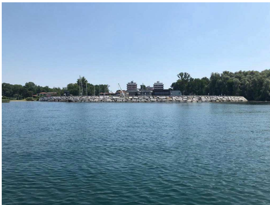
Figura 20 – Stato di fatto
