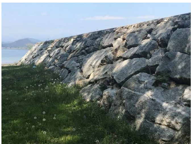
Figura 4 – Stato attuale scogliera Punto di ripresa 2
