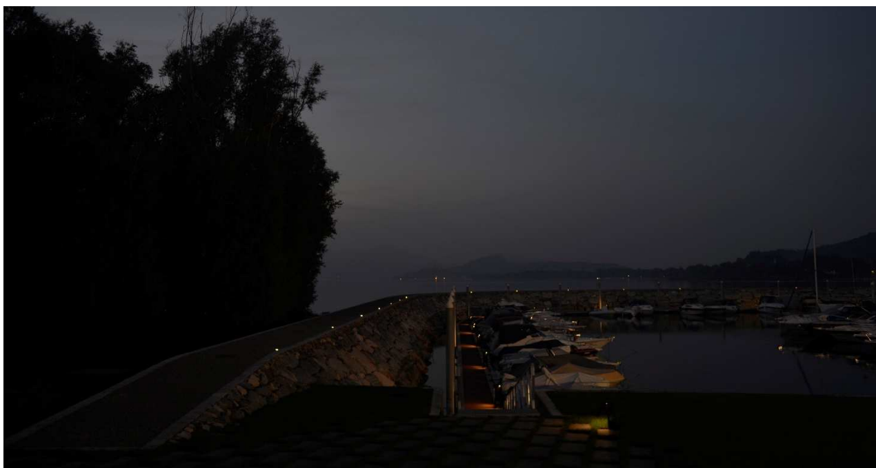
Figura 15 – Vista notturna sulla scogliera con impianto di illuminazione notturna attivo
