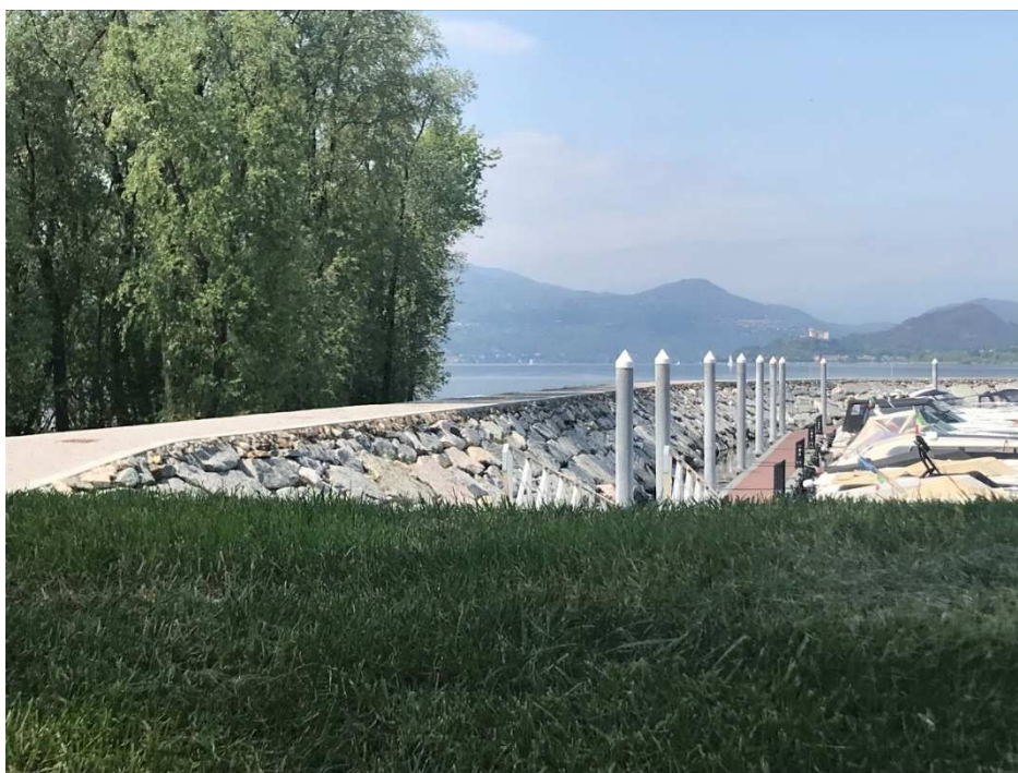
Figura 11 – Stato di fatto dei pali di ancoraggio con copri palo bianco di forma conica
