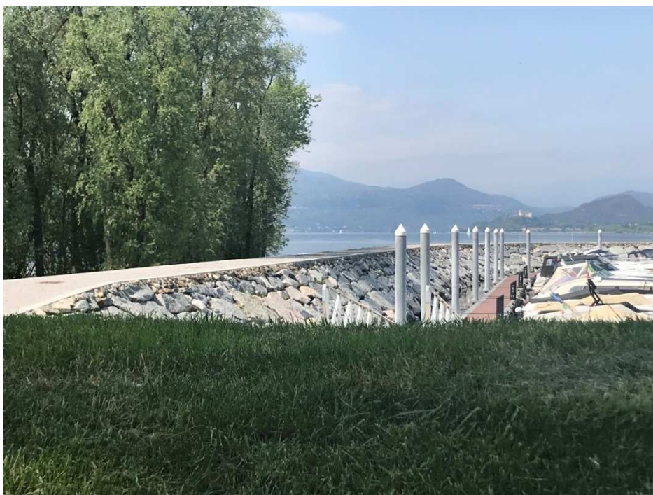
Figura 22 – Stato di fatto
