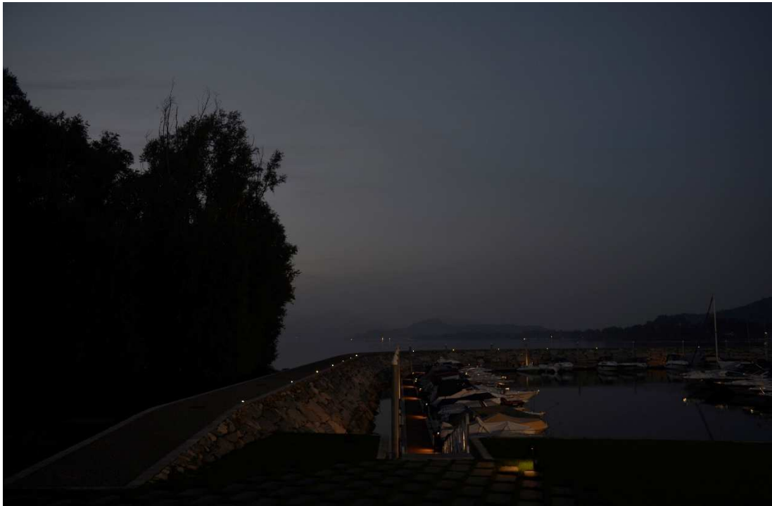
Figura 29 – Area in esame durante le ore notturne con impianto di illuminazione in funzione
