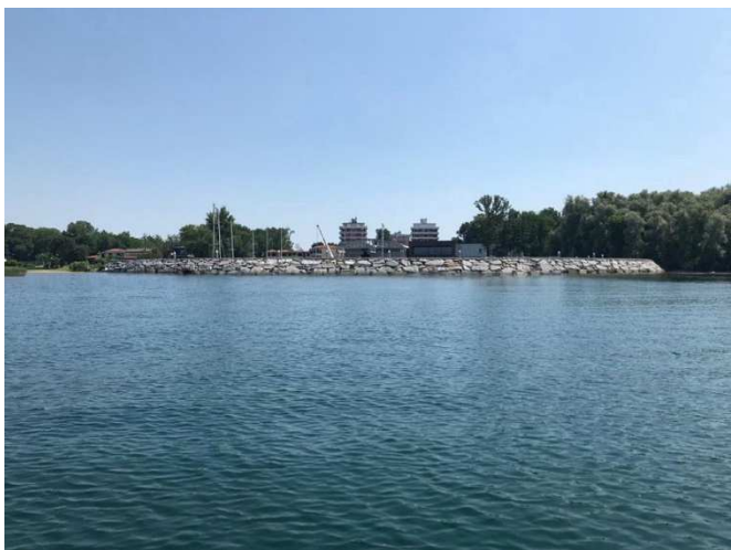
Figura 6 – Stato attuale scogliera Punto di ripresa 3
