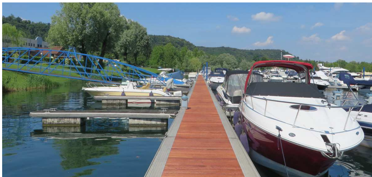
Figura 8 – Struttura galleggiante della Marina di Verbella presso Sesto Calende
