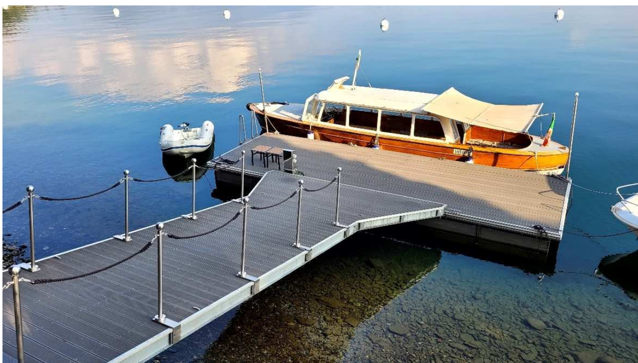
Figura 14 - Esempio di pontile con camminamento in WPC sul Lago Maggiore presso Cannero Riviera (VCO)
