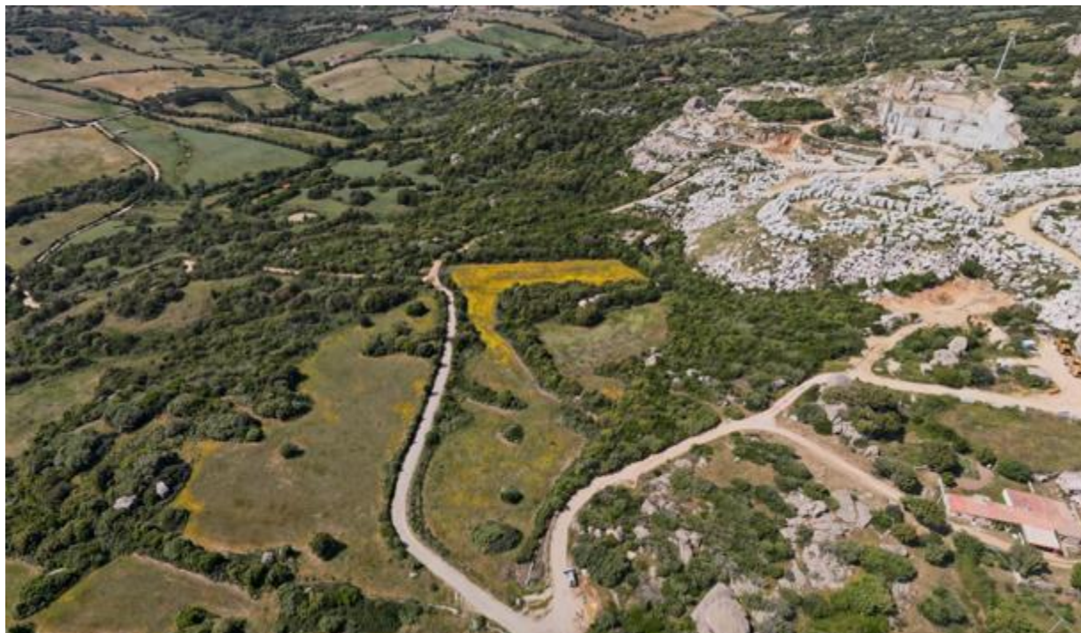
FOTO AEREA POSIZIONE TURBINA MIS_1
