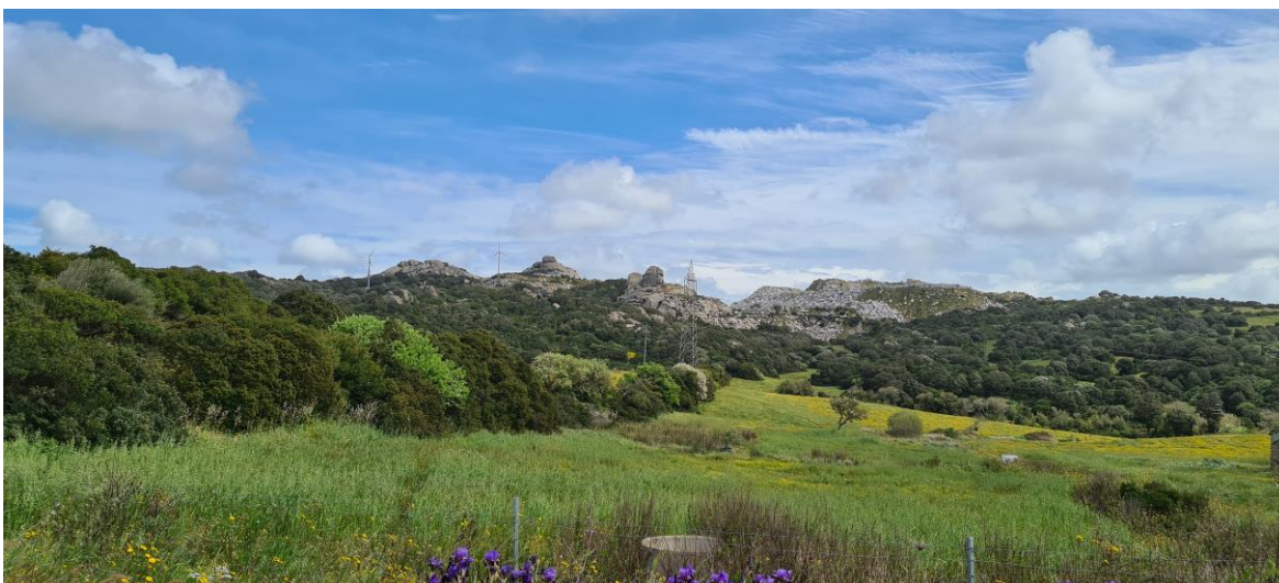
Figura 3-3: Macchia alta e cave di granito si inseriscono attraversate dalla rete elettrica di media tensione.
