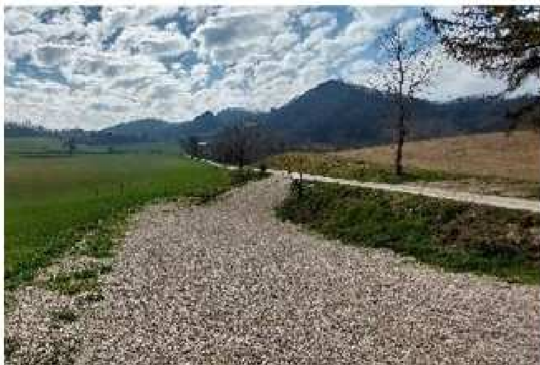
Foto_ 7 Strada di crinale, dove nel versante verrà realizzata la spalla del viadotto
