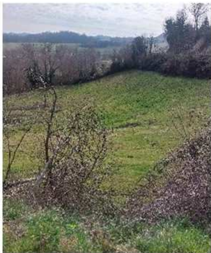
Foto_ 5 Vista da Nord della scarpata di frana - Colamento
