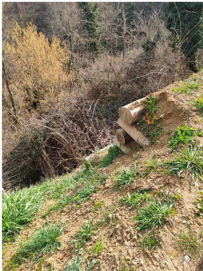
Foto_ 10 Interventi di stabilizzazione del vecchio tracciato della SS. 78
