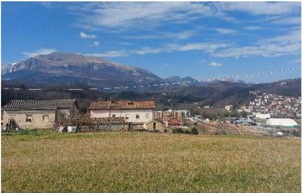
Foto_ 3 Abitazioni adiacenti alla galleria
