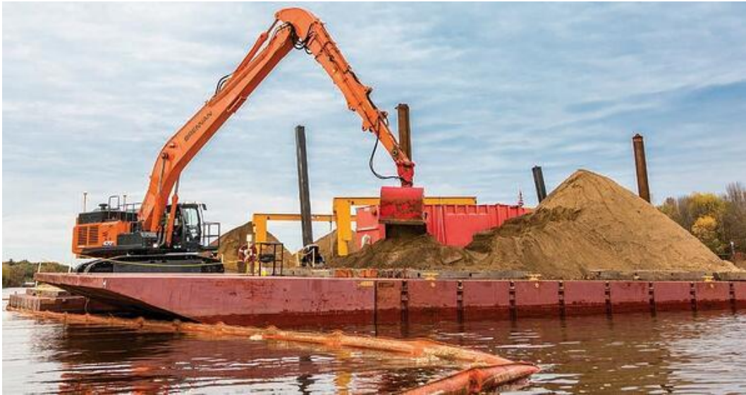
Figura 8. Chiatta dotata di escavatore e benna mordente area conterminata da panne (Fonte: elaborazione propria).
