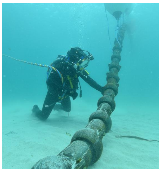
Figura 7:13: Esempio di metodo di posa con gusci di protezione [Fonte: Farinia Group]
