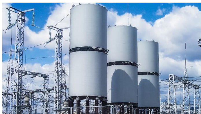
Figura 7:22: Esempio di reattori di shunt isolati in aria [Fonte: Trench Group]
