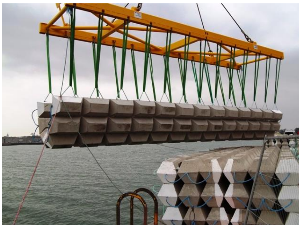
Figura 7:11: Protezione di un cavo sottomarino con cubicoli [Fonte: Subsea Protection Systems Ltd]
