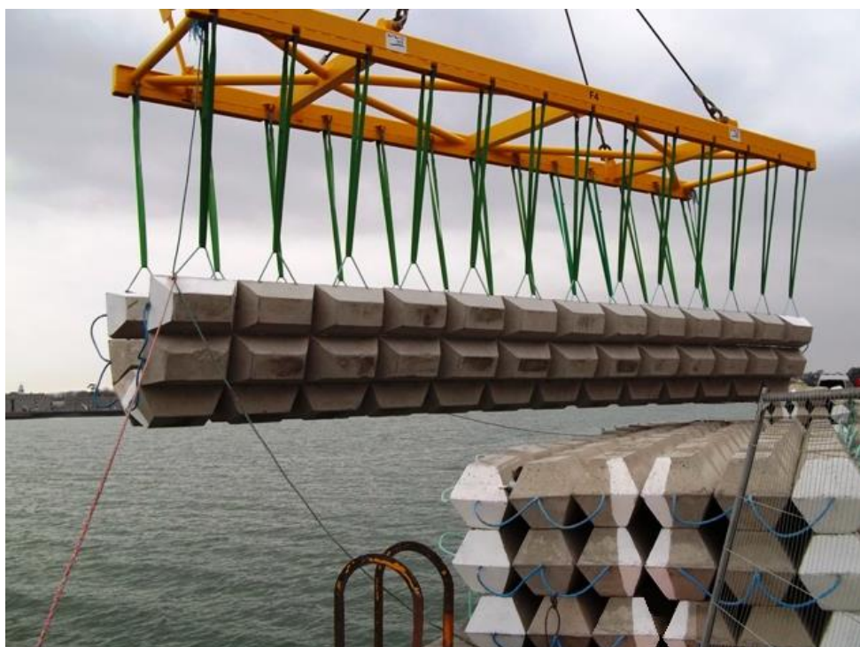
Figura 2.12: Protezione di un cavo sottomarino con cubicoli [Fonte: Subsea Protection Systems Ltd]
