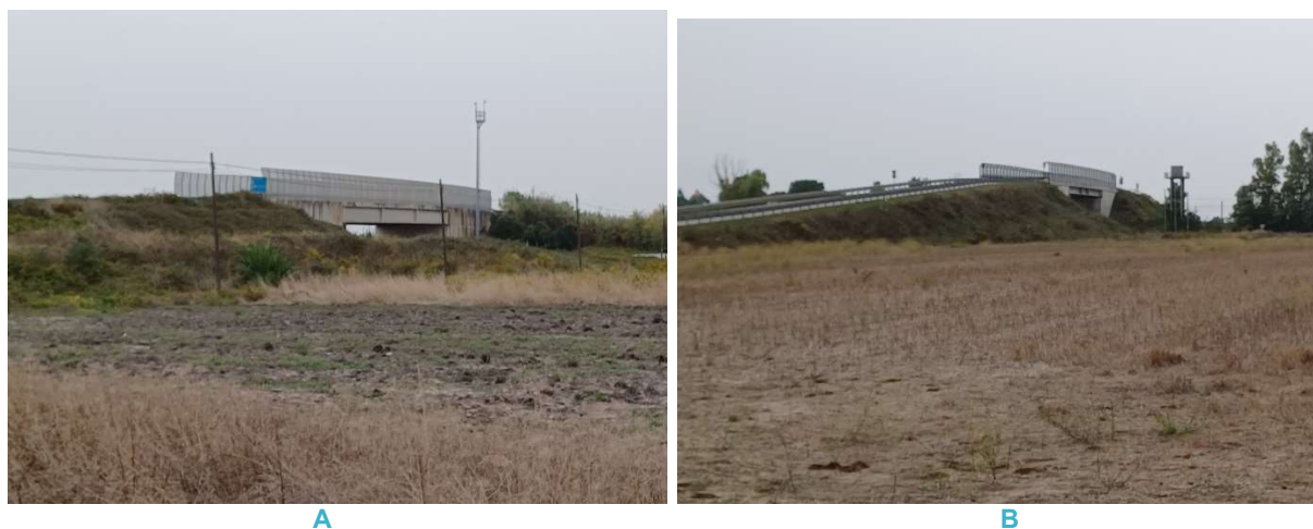
Figura 4.6: Viadotti su superstrada Brindisi Lecce (A) e sulla ferrovia (B)
