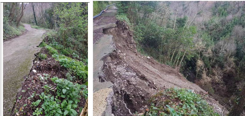
Figura 2 stato di fatto di via Lavinola
