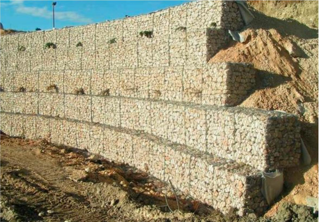
*Figura 5. Esempio di gabbionate rinverdite*
