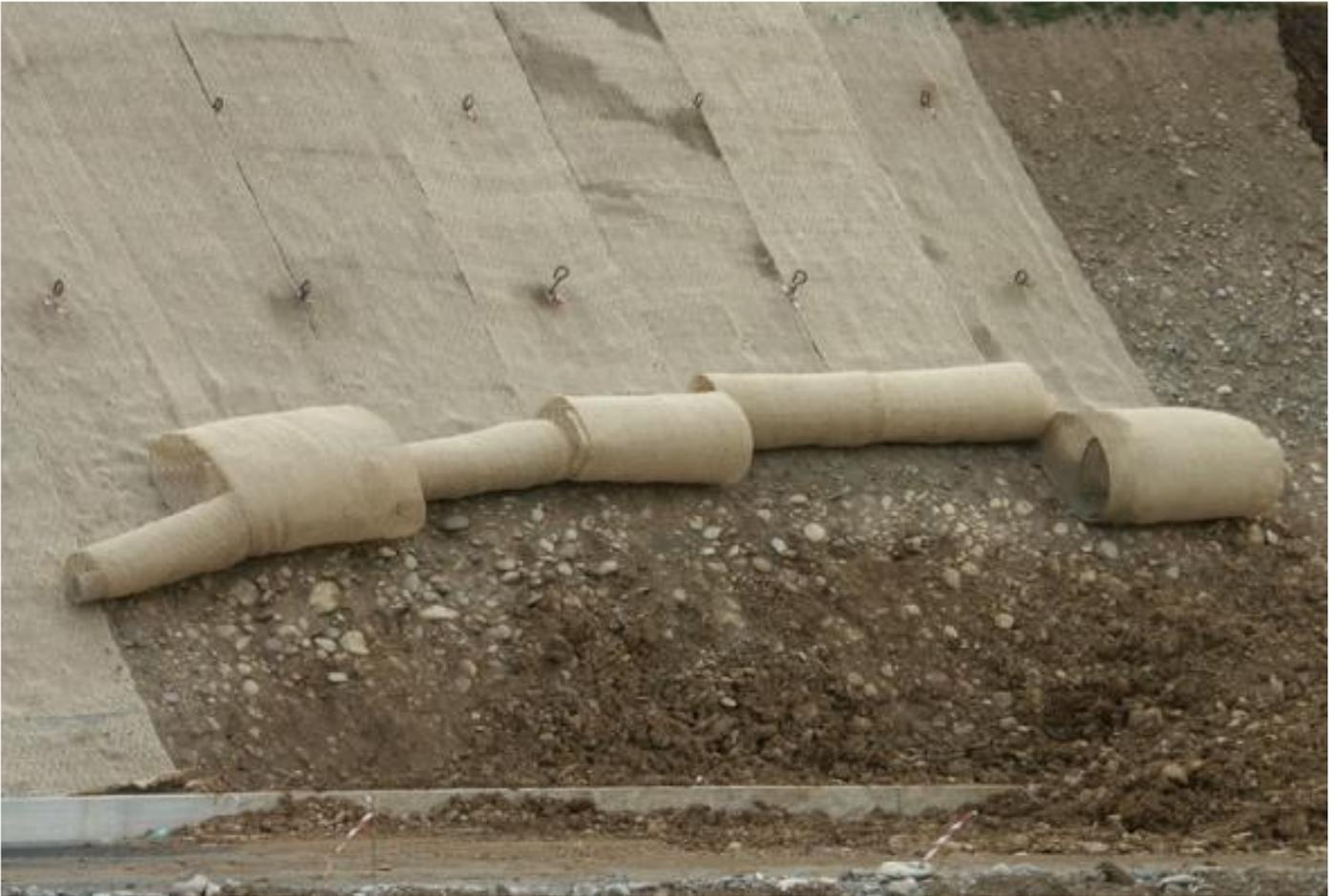
*Figura 7. Esempio di rivestimento in geostuoia*
