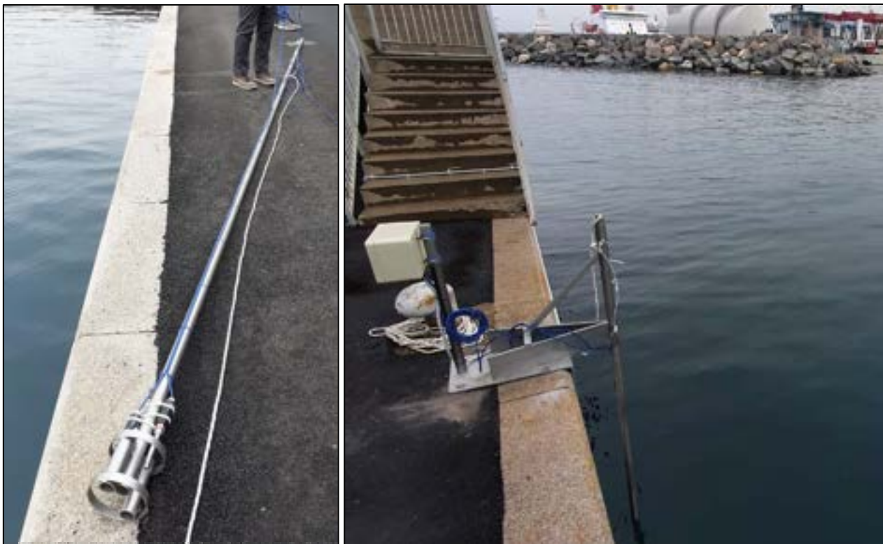
Figura 9: a sinistra il palo in acciaio inossidabile in tutta la sua lunghezza alla cui estremità sono state agganciate le sonde, a destra la struttura di allaccio alla banchina
