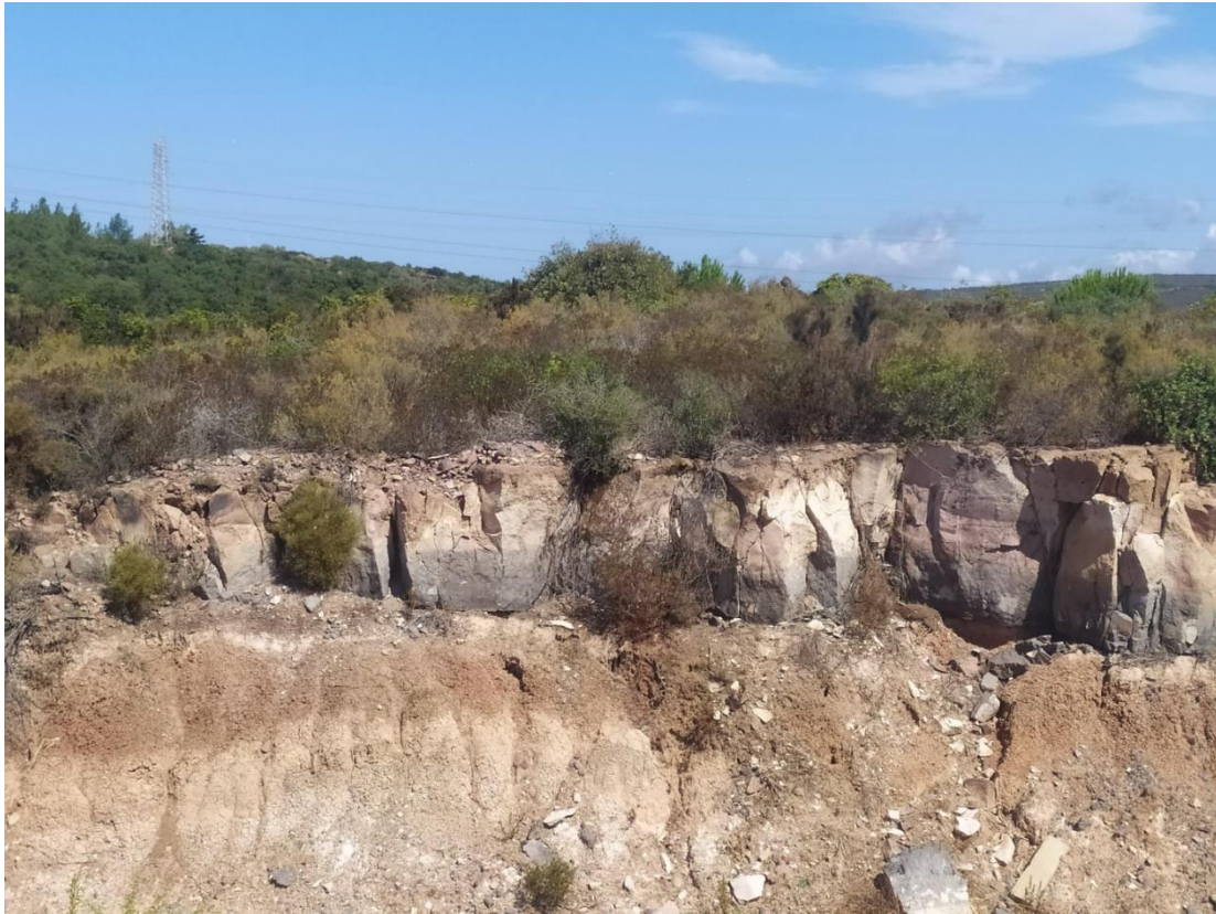
Figura 5.16: Zona basale delle Rioliti di Nuraxi affiorante di fianco la strada (tracciato di cavidotto) che da Cortoghiana conduce a Nuraxi Figus, alle coordinate 452226.27 m E- 4340751.92 m N, in prossimità del ponte che supera il Riu Sturruliu. L'immagine mostra in maniera estremamente chiara il livello vitrofirico basale di colore scuro e in parte, soprattutto sulla destra, i livelli da caduta decimetrici che appoggiano sulle sottostanti Rioliti di Monte Crobu.
