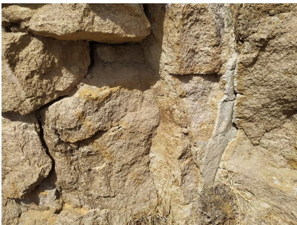
Figura 5.15: Rioliti di Nuraxi nei pressi di Nuraxi Figus (coordinate 451333.29 m E- 4341175.83 m N), in cui si apprezza fessurazione verticale con alterazione per devetrificazione.
