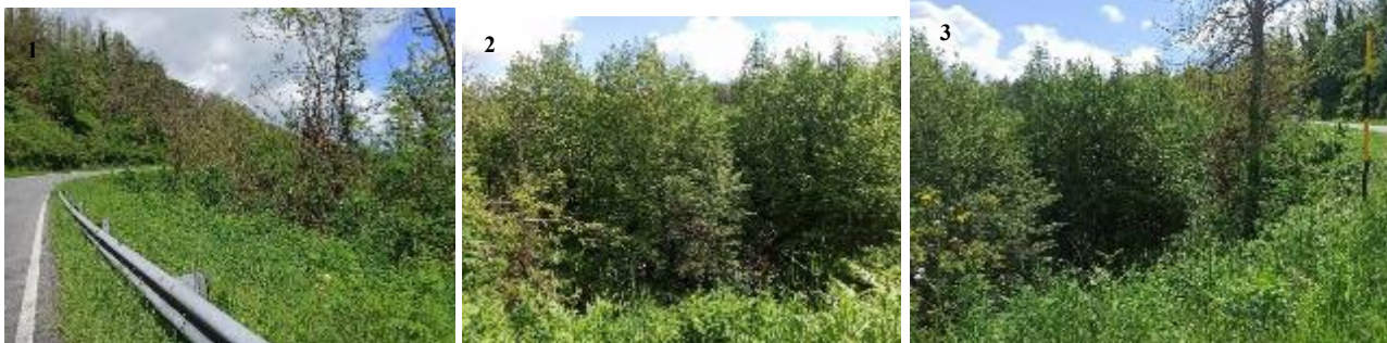
Figura 13 Stato dei luoghi presso Viadotto VI.02 (cfr. sopralluogo del 14/09/2023)
