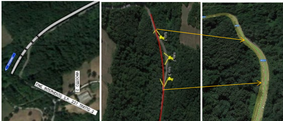
Figura 12 Viadotto denominato VI02
