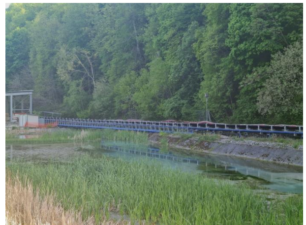
Absetzbecken Vasche di decantazione
