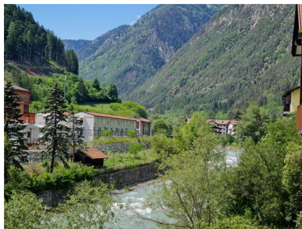
Blick von der Hauptstraße auf die Baustelle
