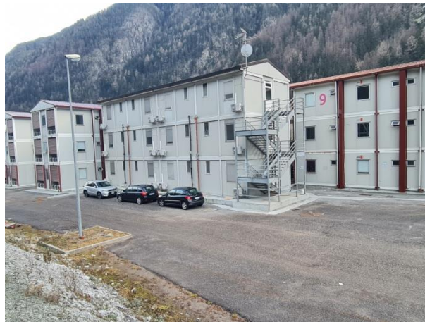
Teilansicht der Baustelle / Scorcio area di cantiere
