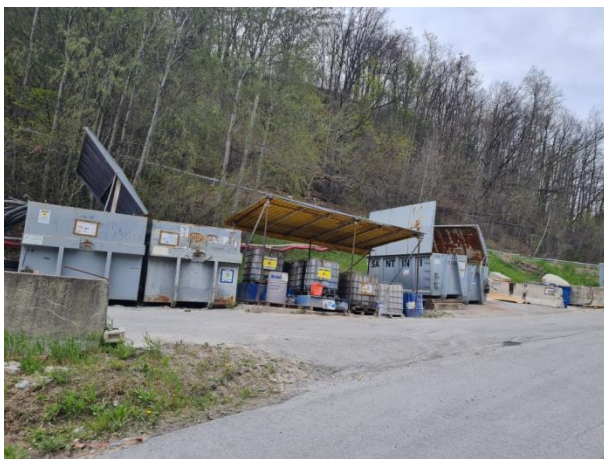
Baustelle Unterplattner / Cantiere di Unterplattner
