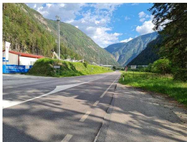
Ansicht der Baustelle Muls 1 von der Staatsstraße Vista del cantiere di Muls 1 dalla strada statale
