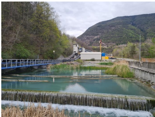
Wasseraufbereitungsanlage Impianto trattamento acque
