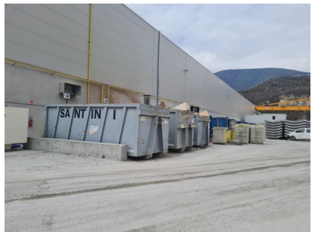
Baustelle Hinterrigger / Cantiere di Hinterrigger
