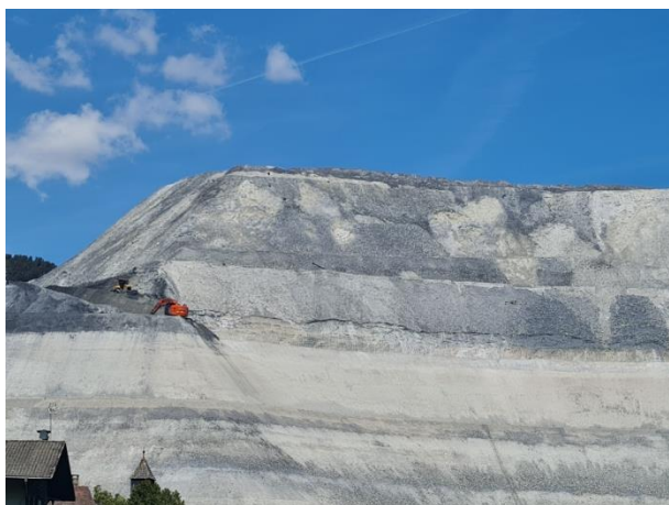
Umgestaltung der Haldenhänge / Rimodellazione delle scarpate
