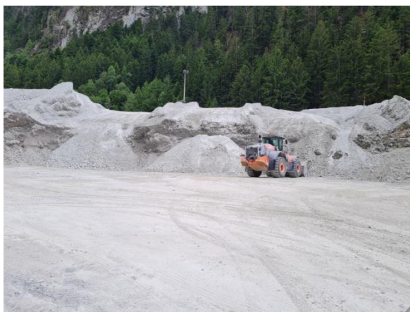
Endlagerung gneiss abbruch
