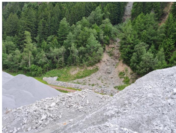
Sichereithdamm für Murgänge
