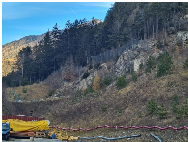
Steinschlagnetze am Hang über der Baustelle / Reti paramassi sul versante che sovrasta il cantiere
