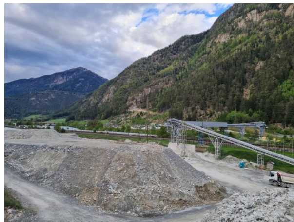
Lagerflächen Aushub Material Tunnel Muls / Aree di stoccaggio materiale di scavo della galleria di Muls
