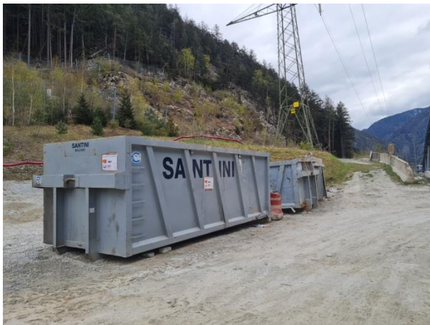
Baustelle Muls1 Cantiere di Mules1
