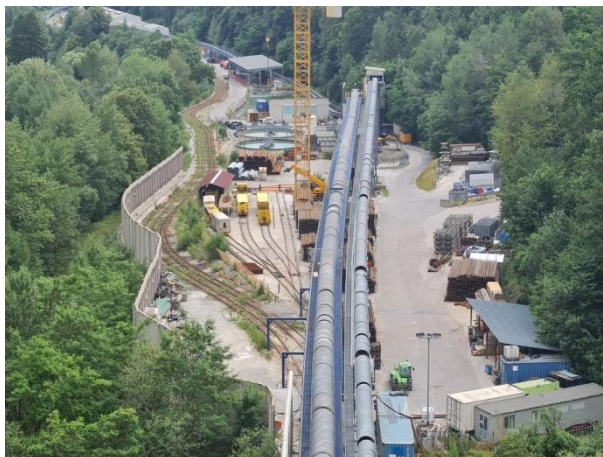
Teilansicht der Baustelle Scorcio area di cantiere
