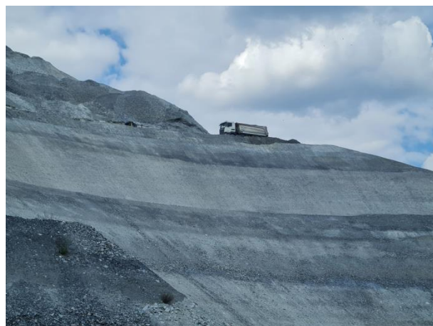
Umgestaltung der Haldenhänge / Rimodellazione delle scarpate
