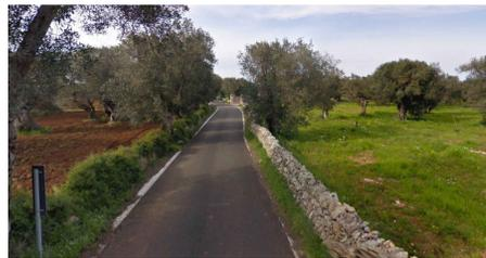
**TIPOLOGIA 1.2: Viabilità esistente in conglomerato bituminoso in pessimo stato**
