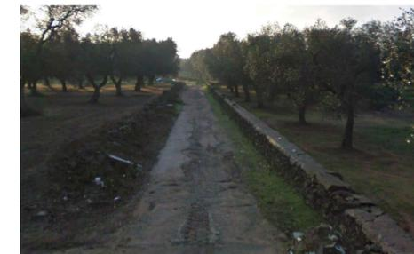
**TIPOLOGIA 2: Viabilità esistente con pavimentazione naturale in discreto stato**
