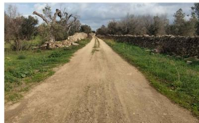
**TIPOLOGIA 2.2: Viabilità esistente con pavimentazione naturale in pessimo stato**
