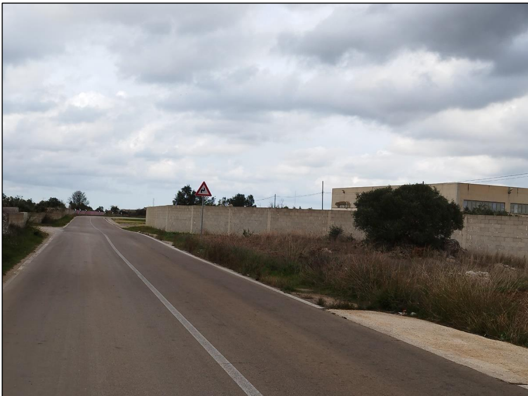
Foto 16: Strada Provinciale Casalabate 236 o Via Benedetto Croce, area di impianto della SU01
