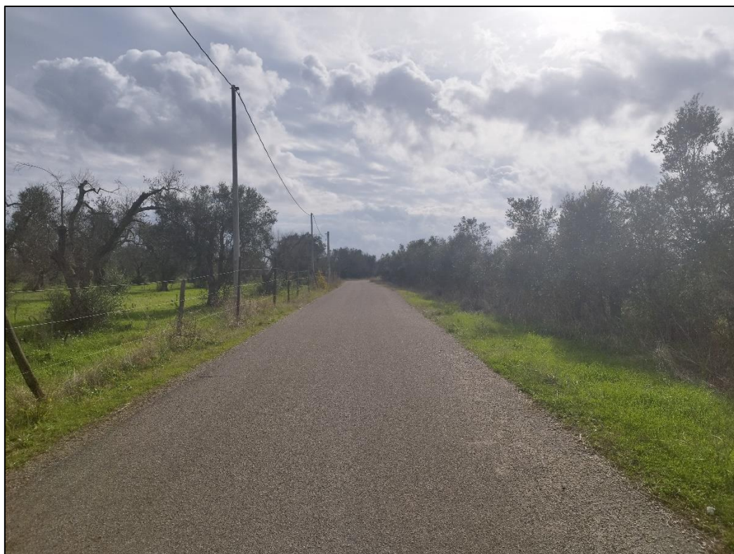
Foto 10: Strada Comunale Surbo-Torchiarolo, verso le aree di impianto della TR01
