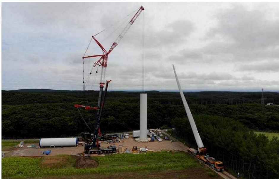
Figura 6 – Fasi di montaggio dell'aerogeneratore.
