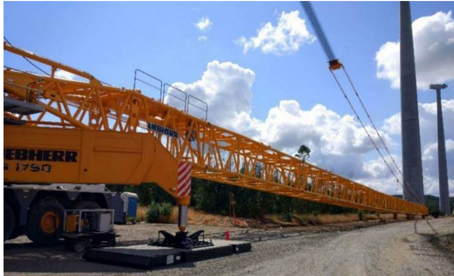
Figura 5 – Fasi di montaggio della gru principale.
