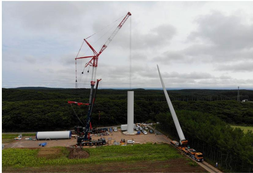
*Figura 4 – Montaggio dell'aerogeneratore con gru principale.*
