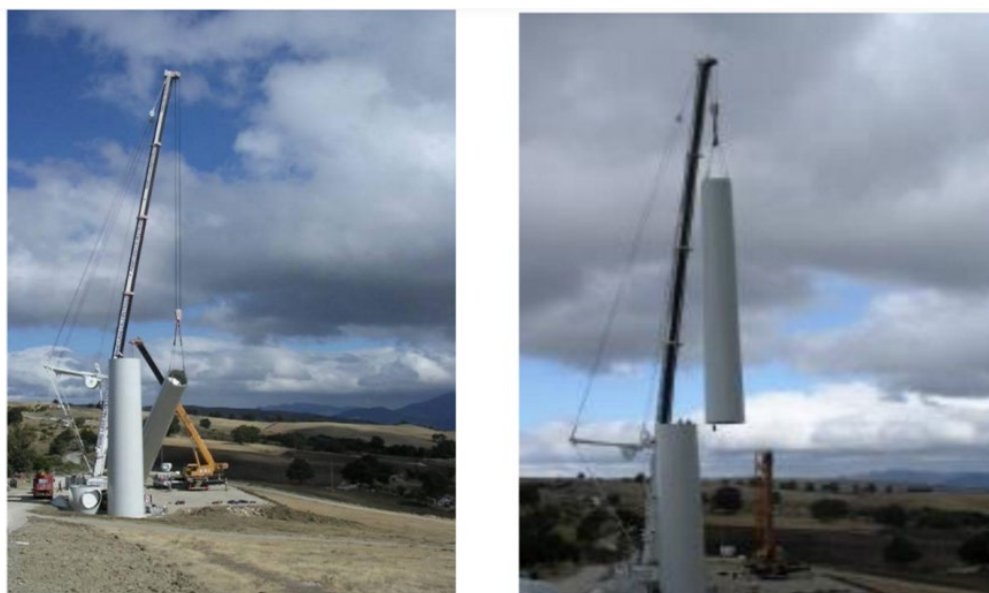
Figura 26 – Fasi di montaggio della torre dell'aerogeneratore.
