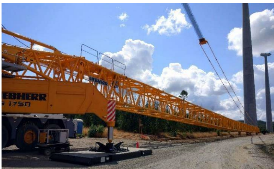
Figura 14 – Fasi di montaggio della gru principale.
