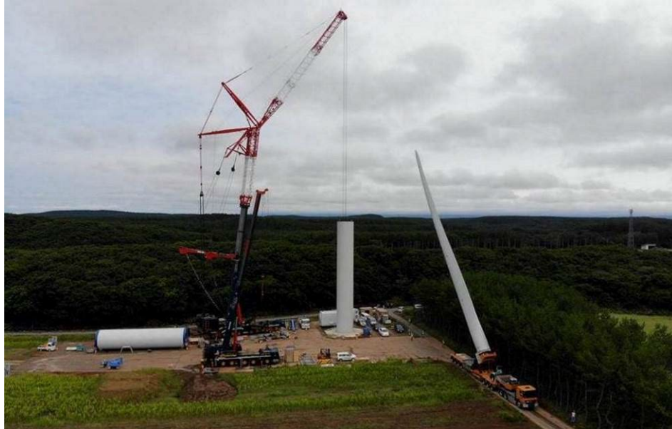
Figura 15 – Fasi di montaggio dell'aerogeneratore.
