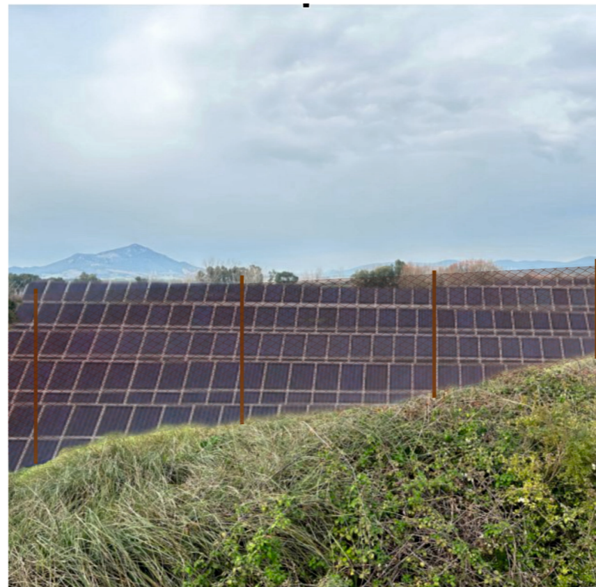
Vista della stessa porzione dell'insediamento in fase di realizzazione dell'opera
