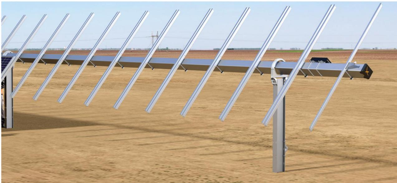
Figura 6: struttura tipo di sostegno dei trackers.
