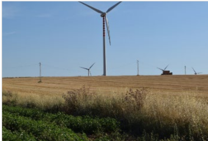
Fig. 25 Dietro alla prima pala sorgerà l'impianto
