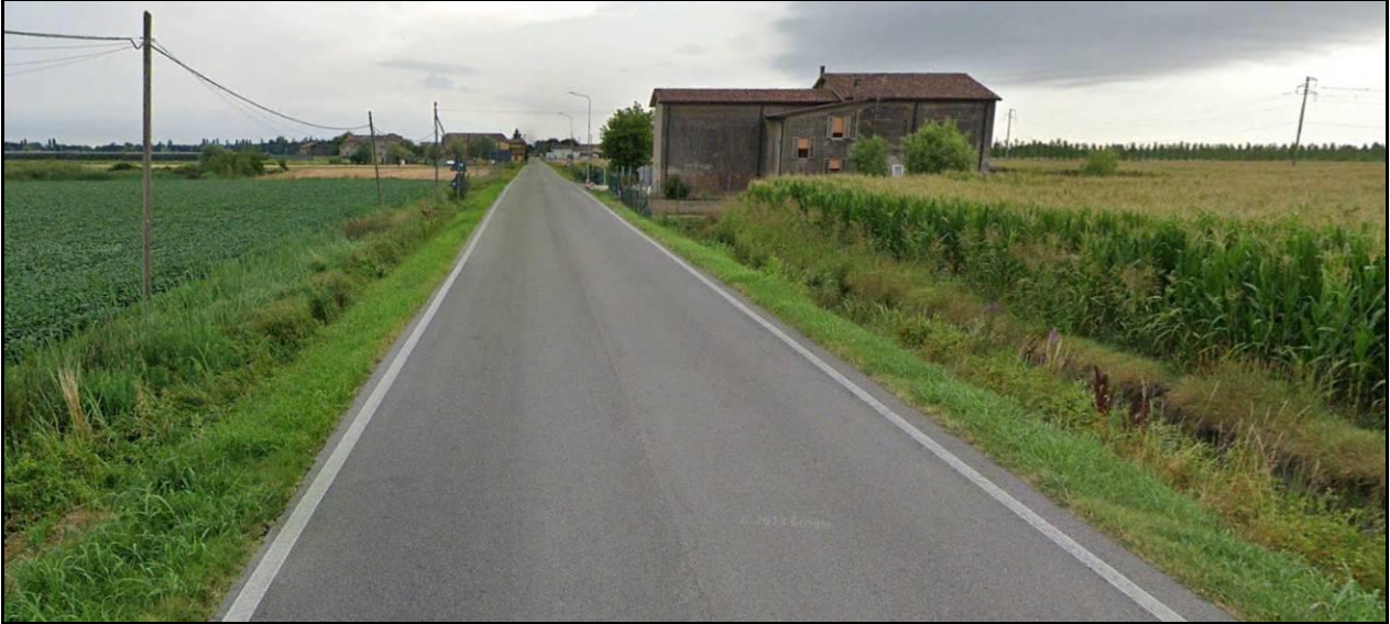
SP 15 - Tratto iniziale
