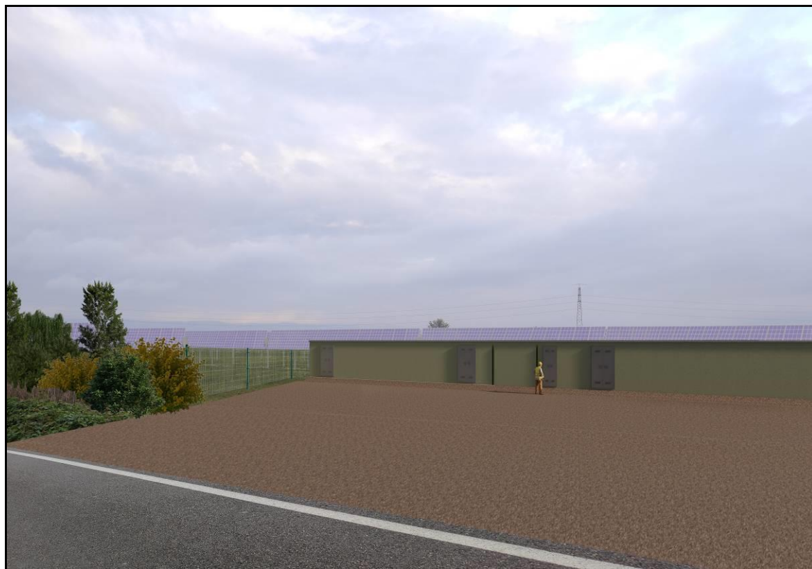
Foto 6: punto di vista 6, da Ovest da Via Tenuta Spalletti – Zona cabine
