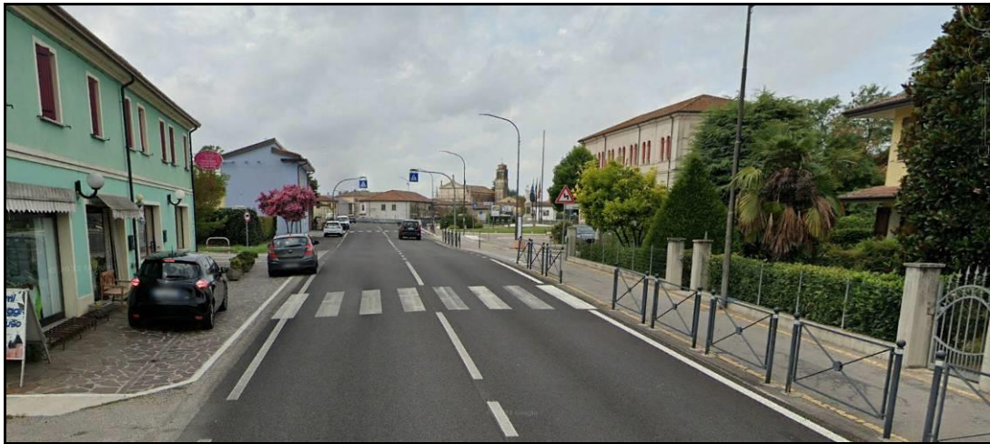
Attraversamento abitato di Baruchella
