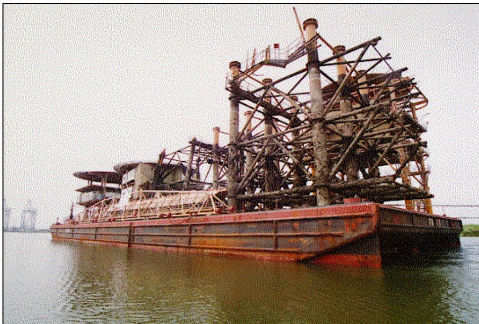
Figura 3-57: trasporto delle strutture rimosse
