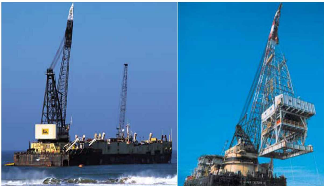
Figura 3-43: immagini del pontone di installazione della piattaforma ( crane-barge )
