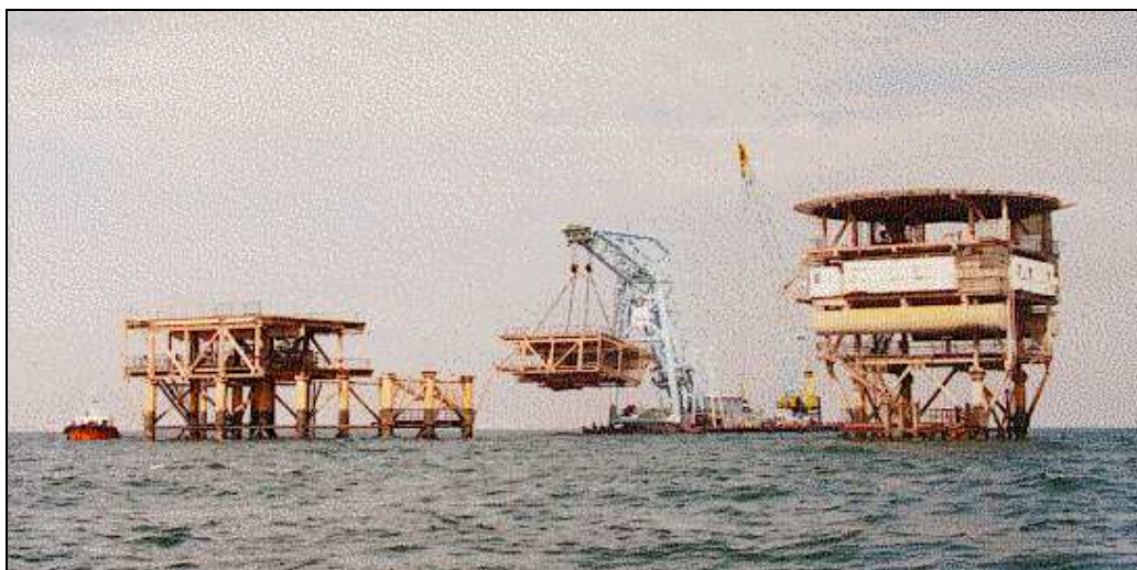
Figura 3-53: sollevamento di un Deck
