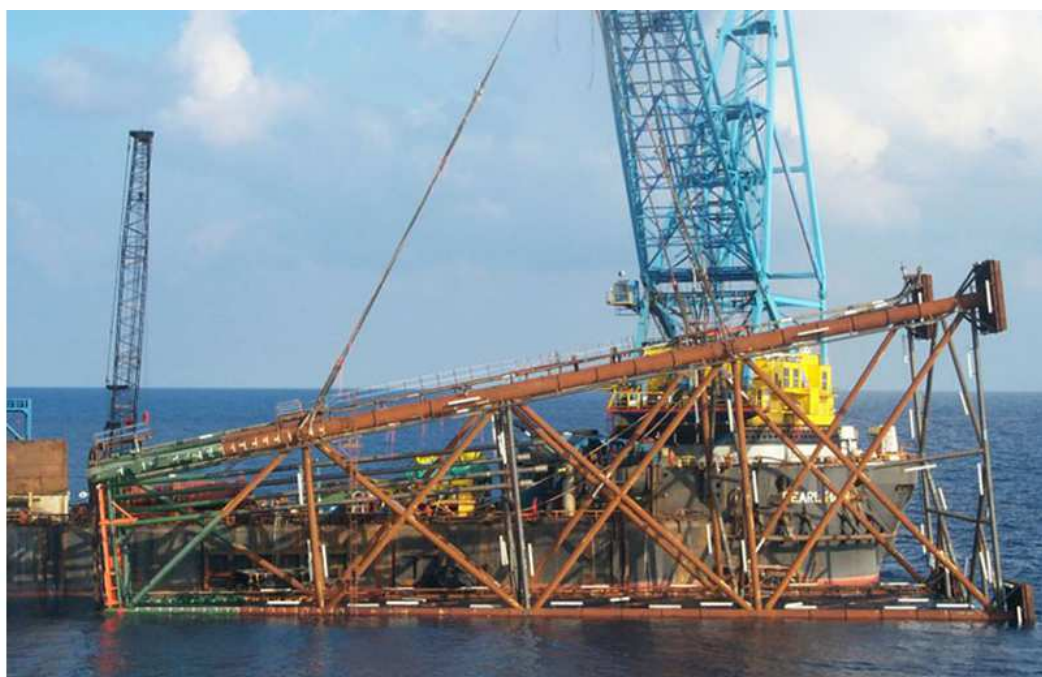
Figura 3-33: fase di installazione a mare del Jacket
