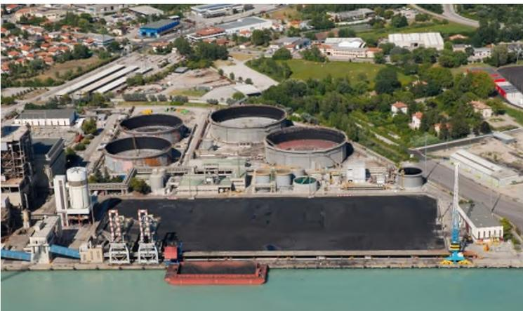
FIGURA 3 - VISTA DEL PARCO CARBONE E DEPOSITO COMBUSTIBILI LIQUIDI DI CENTRALE
