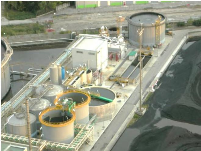
Le acque reflue di Centrale, in base alla tipologia, vengono raccolte da un sistema di reti separate e convoglianti a specifiche sezioni dell'Impianto di Trattamento Acque Reflue (ITAR).
