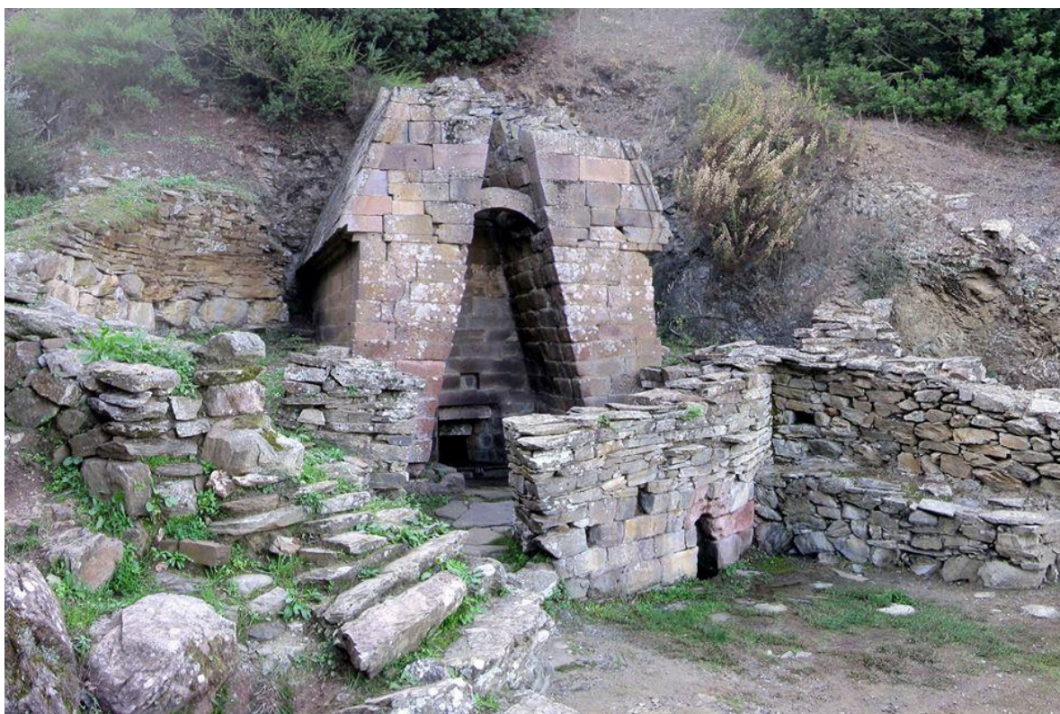
Figura 7.28: pozzo sacro di "Su Tempiesu". Fonte: https://www.sardegnaturismo.it/it/esplora/su-tempiesu
