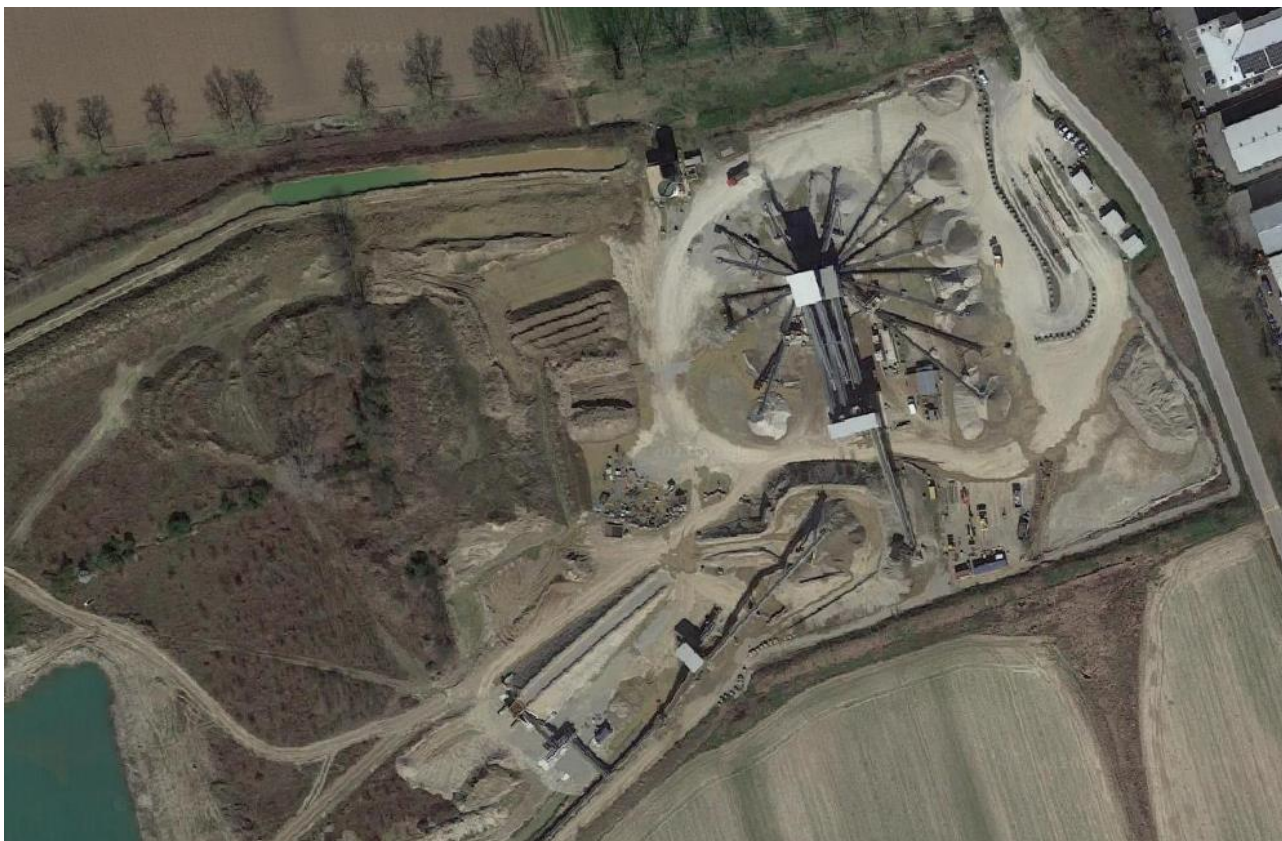
Figura 6-21 – Ortofoto dell'impianto di Pioltello
