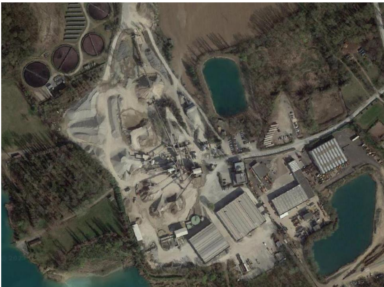
Figura 6-23 – Ortofoto dell'impianto di Brembate
