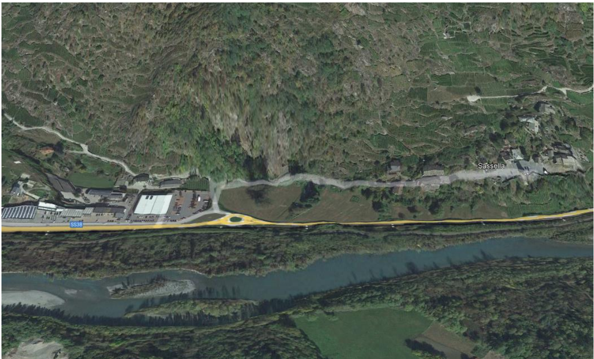
Fig. 1.1 - Vista aerea attuale dell'area di progetto
