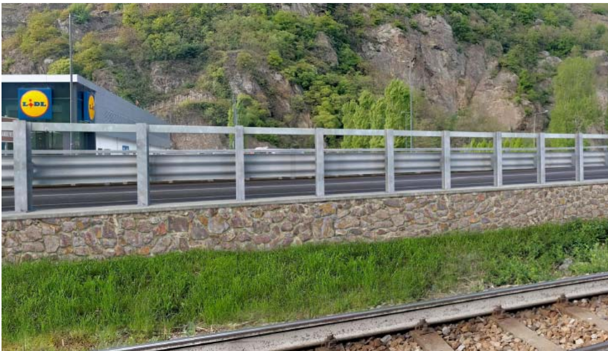
Figura 2-6 - Rivestimento rilevato stradale in corrispondenza della SS38 (zona Lidl)
