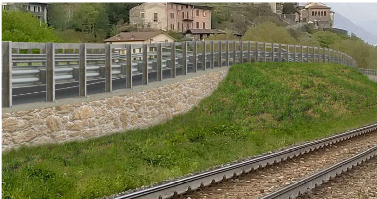
Figura 2-5 - Rivestimento rilevato stradale presso Monastero della Sassella
