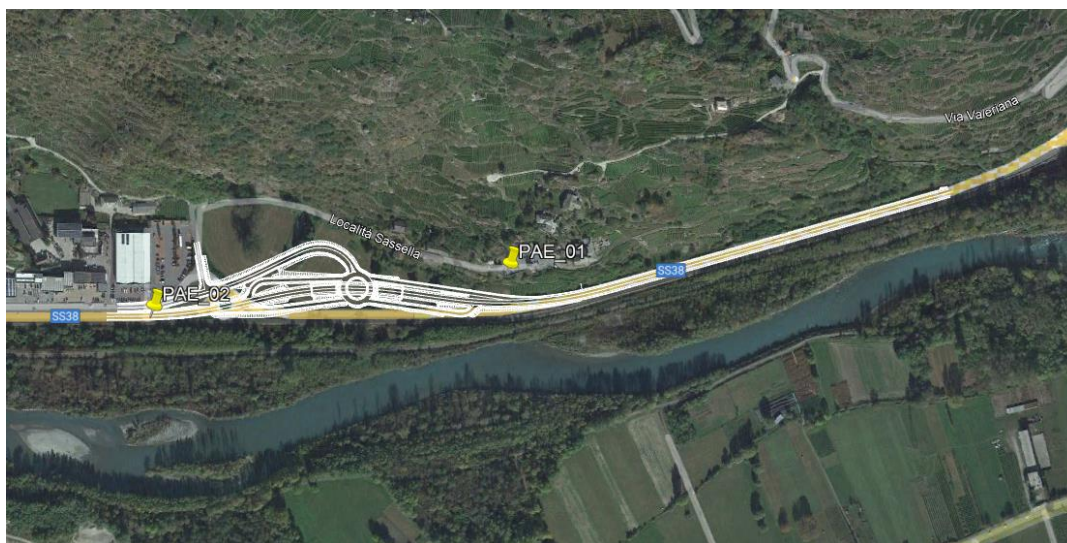
Figura 13-1 Localizzazione dei punti di monitoraggio
