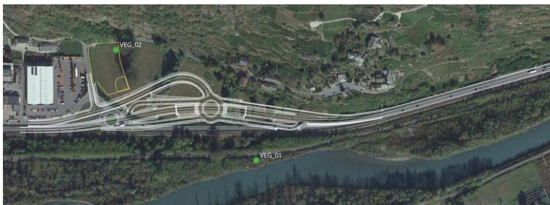
Figura 11-1 Localizzazione dei punti di monitoraggio
