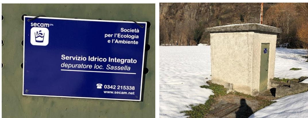
Figura 4: Linea fognaria e locale tecnico SECAM SpA
