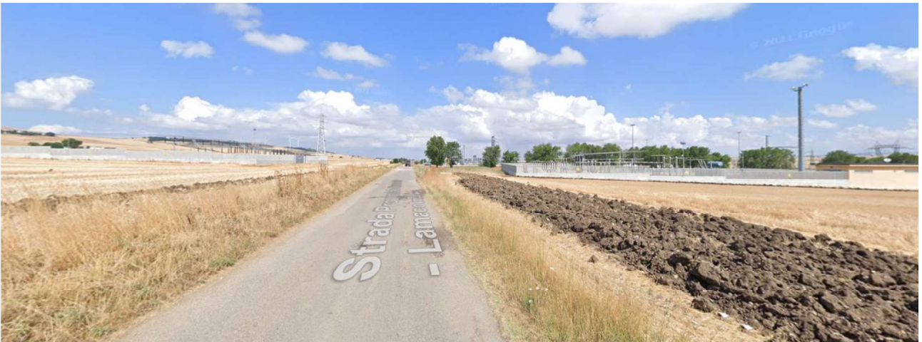
SP 79 in prossimità della stazione esistente di TERNA
