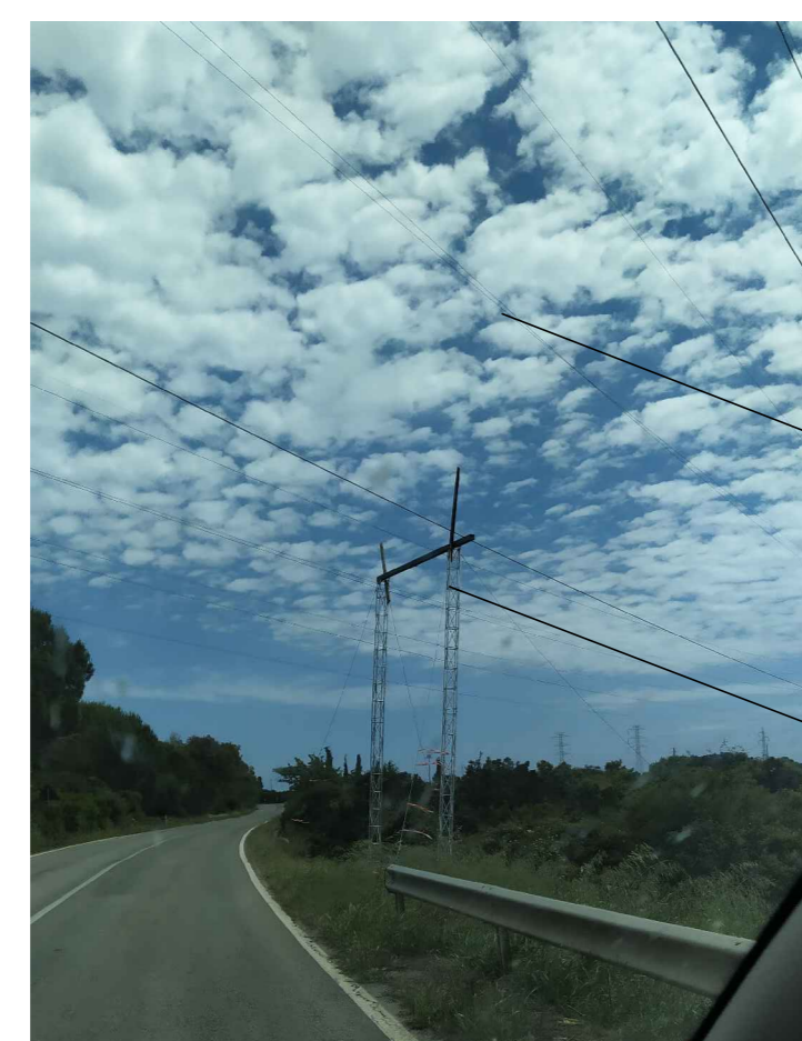
Cavi elettrici Cavalletto per sollevamento cavi elettrici
