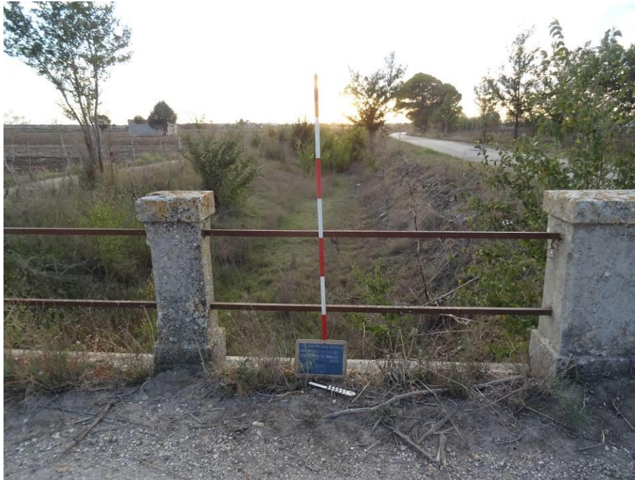
Fig. 40. UR 79, superficie inaccessibile, canale della Cipolla.
