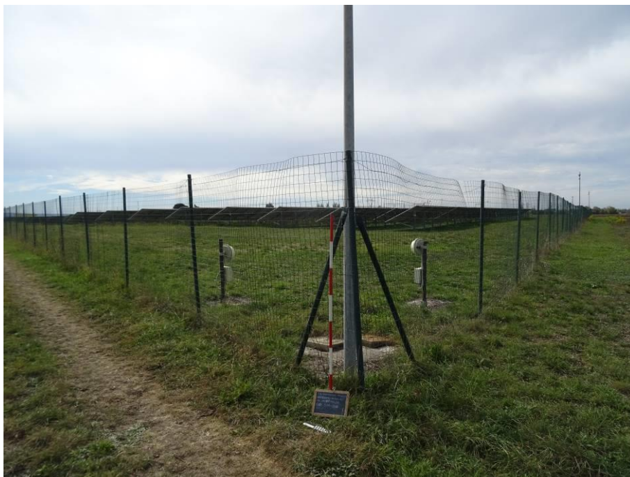
Fig. 41. UR 65, superficie inaccessibile.
