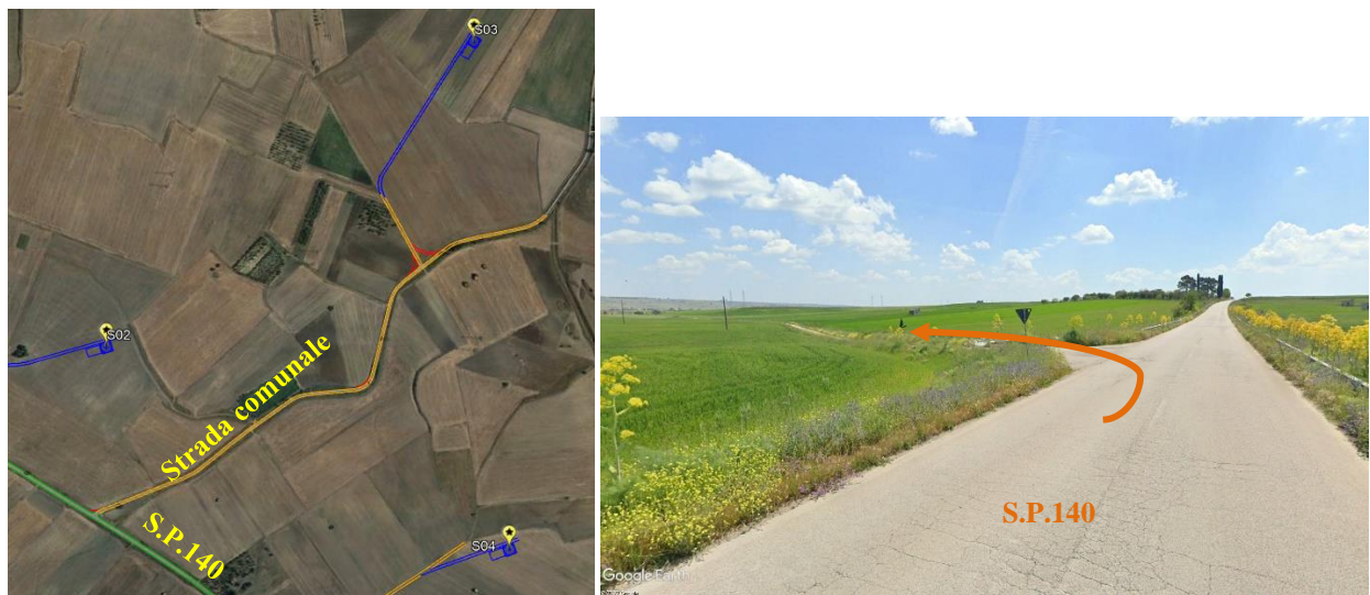
Figura 39 - Immagini della S.P.140 in prossimità dell'accesso per l'aerogeneratore S03
