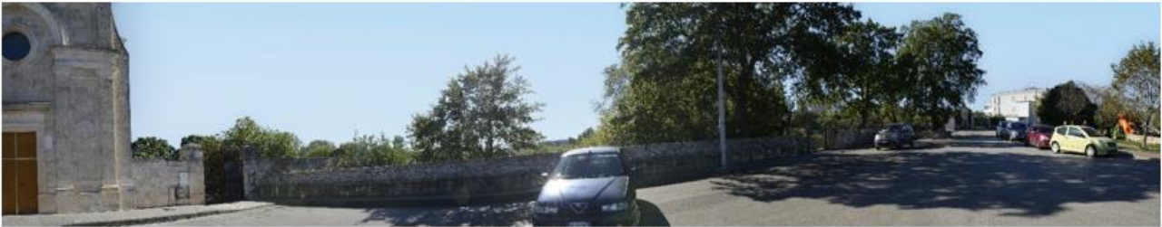
Stato di fatto del F55
