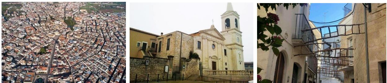
Figura 24 – Centro abitato – Comune di Santeramo In Colle
