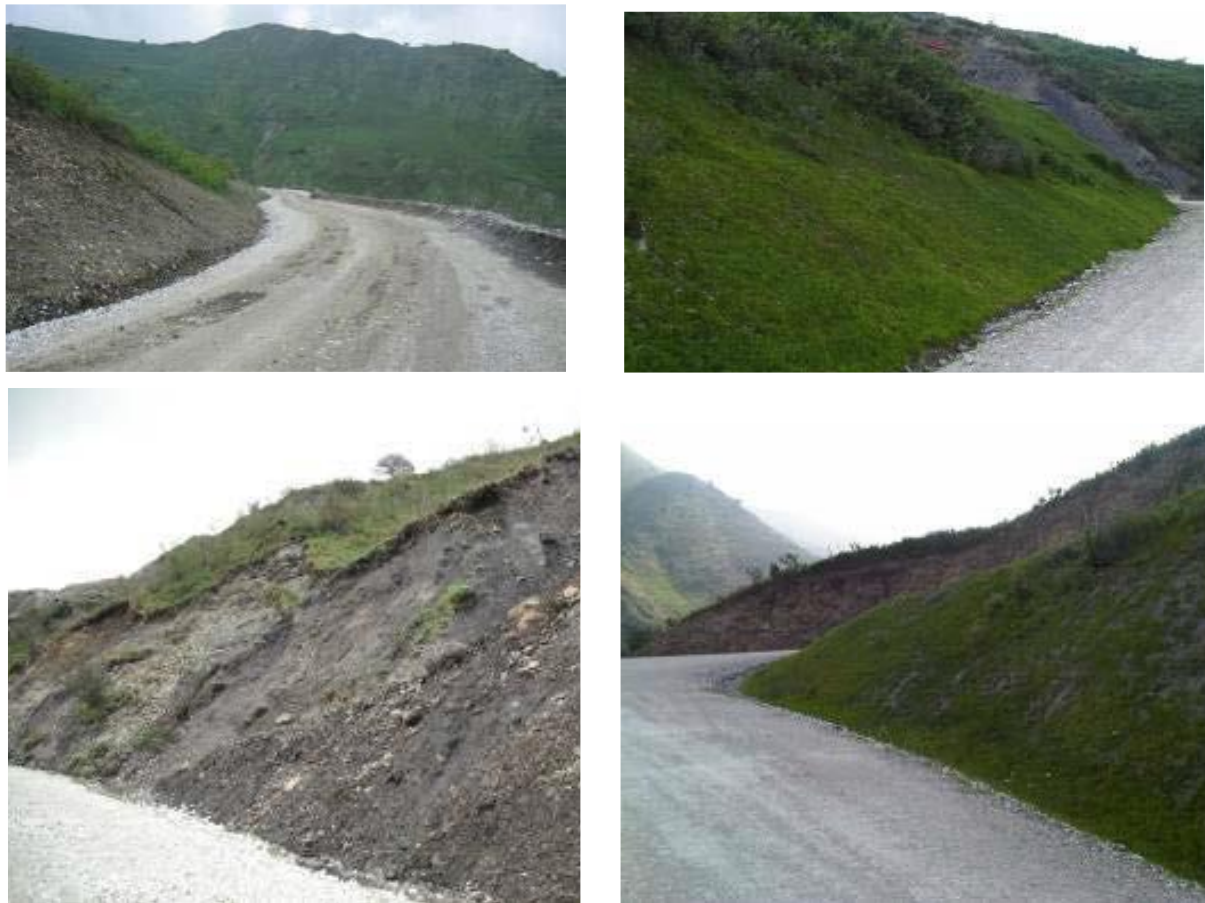
Figura 17 - Esempi di inerbimento post-operam delle scarpate oggetto di intervento, ove e se necessari
