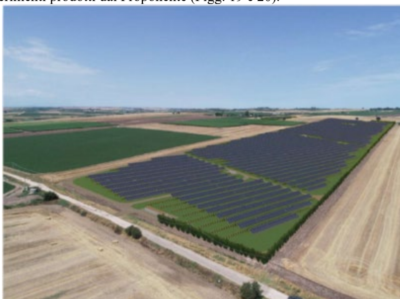
Figura 19 - Vista panoramica da sud
