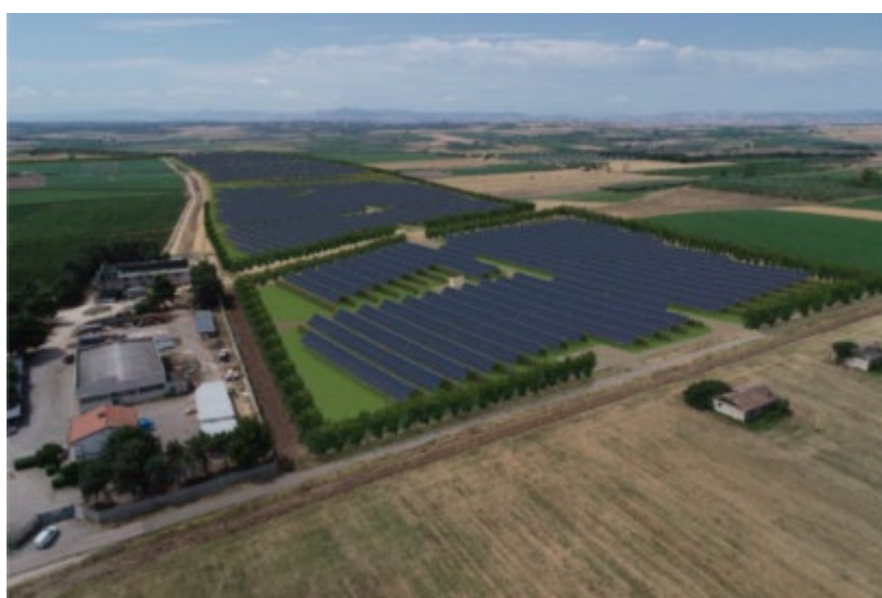
Figura 20 - Vista panoramica da nord
