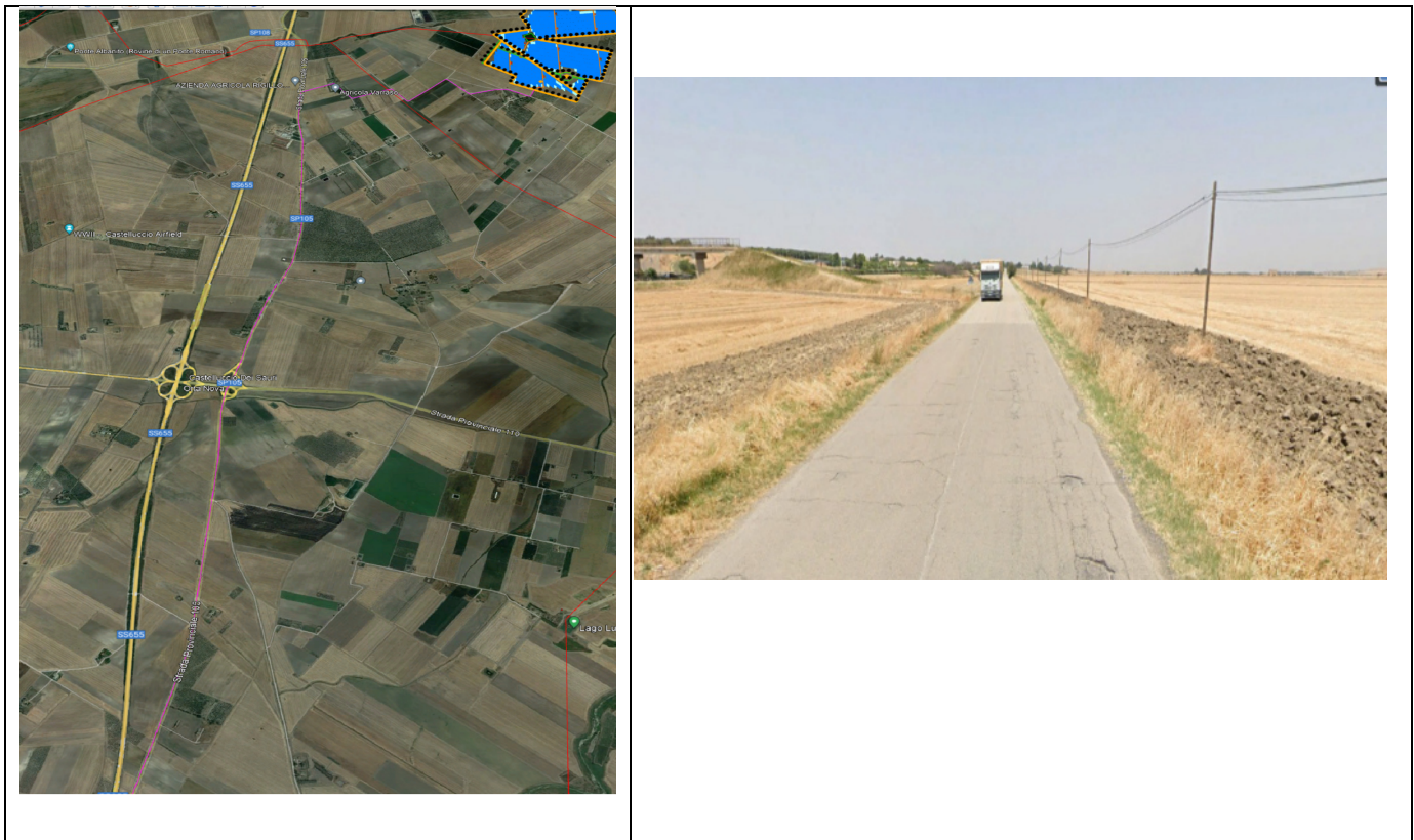
Figura 6 - SP 105: strada asfaltata per l'intero tratto lungo cui corre il cavidotto MT interrato interferendo con i Tratturelli 36 e 38 e con il buffer di 500m da Tenuta Palazzo D'Ascoli
