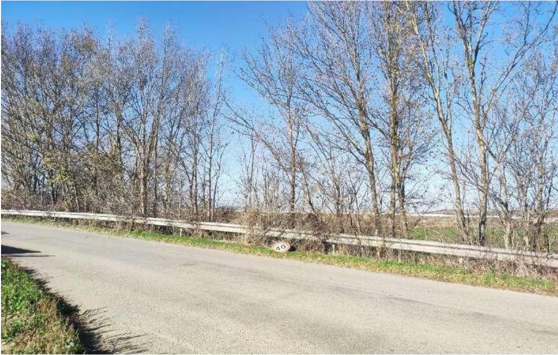
Foto 17a – Punto di Presa n° 17 Stato di Fatto
