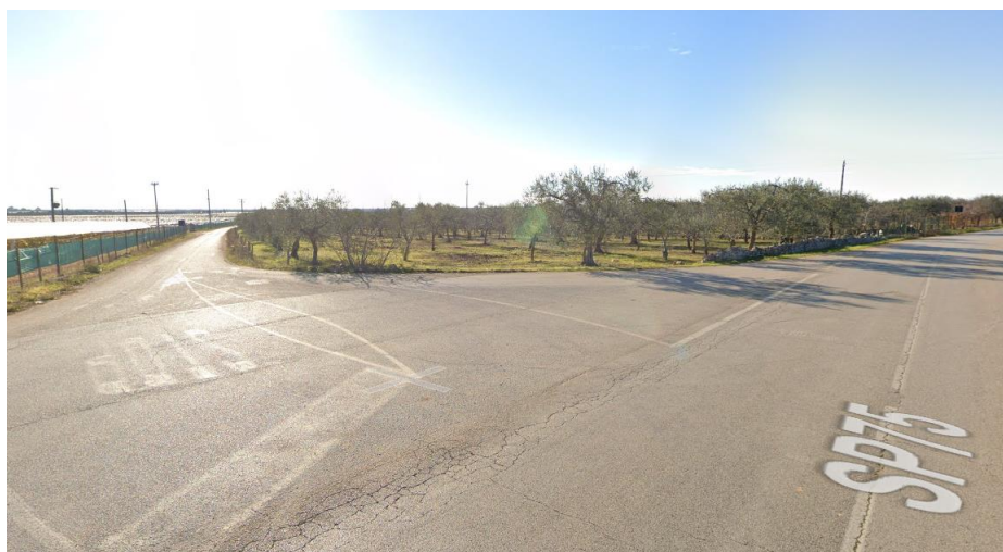
Figura 0-2: Bivio tra Strada Provinciale SP 75 e Strada vicinale Tarantina
