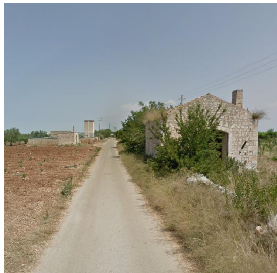
Riscontro fotografico che dimostra la presenza di un piccolo edificio di culto (recettore mantenuto) e la presenza di alcuni edifici collabenti non presenti in catasto fabbricati (recettore scartato)
