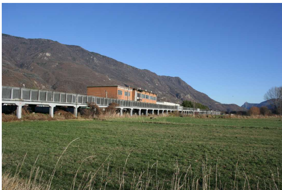
Figura 11 - Tratto di canale NIE sopraelevato in comune di Bruzolo
