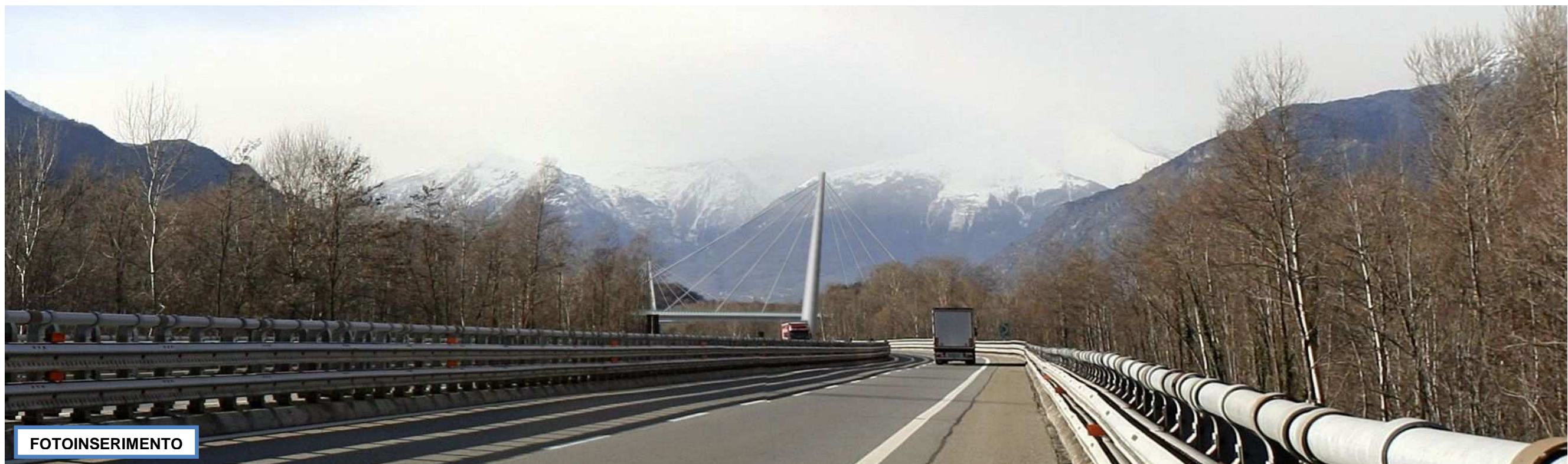
Figura 22 – Stato attuale e fotoinserimento del ponte est (e ovest in secondo piano), vista dall'autostrada (VISTA 1)
