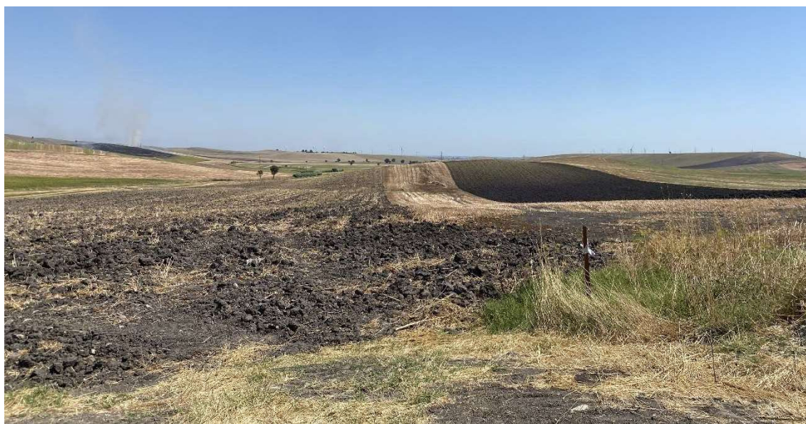
8— report fotografico aree di impianto
