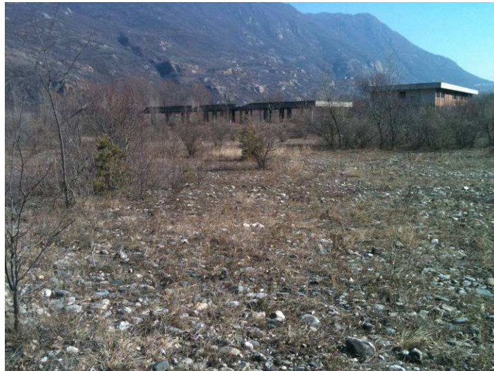
Figura 10 - Edifici moderni, visti da SW; terreno in ciottoli, ghiaia e clasti lapidei
