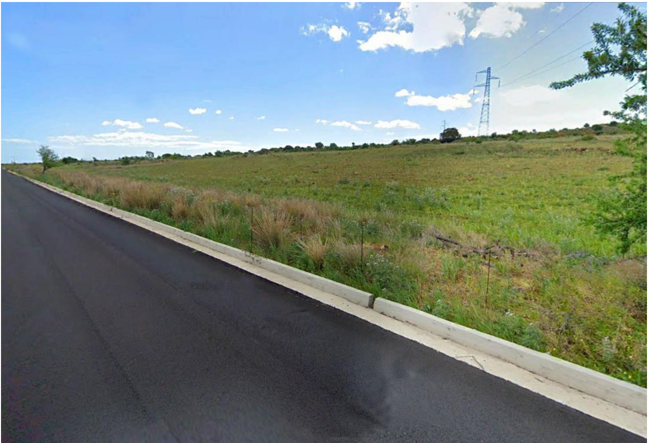
Figura 19 – Vista 2 – Ante operam
