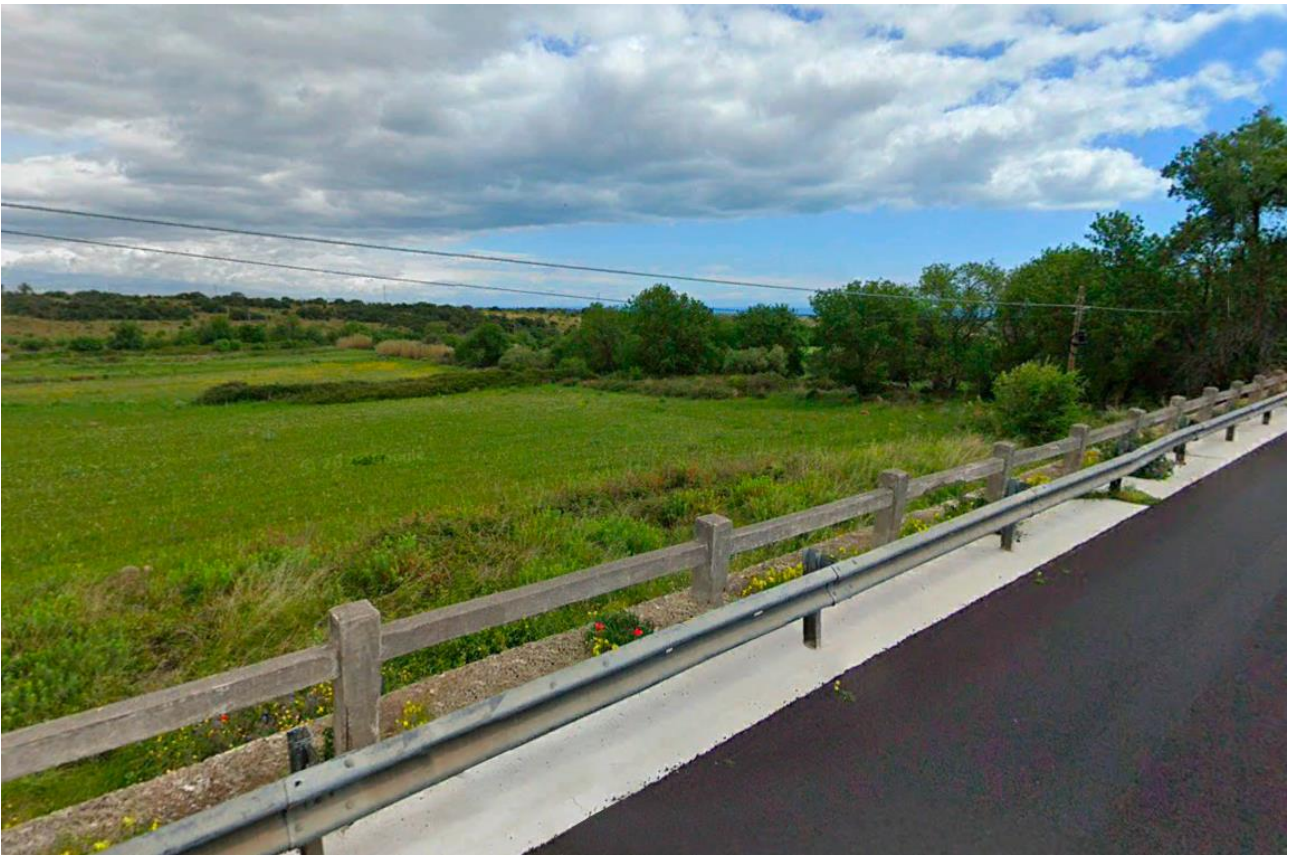
Figura 25 – Vista 5 – Ante operam
