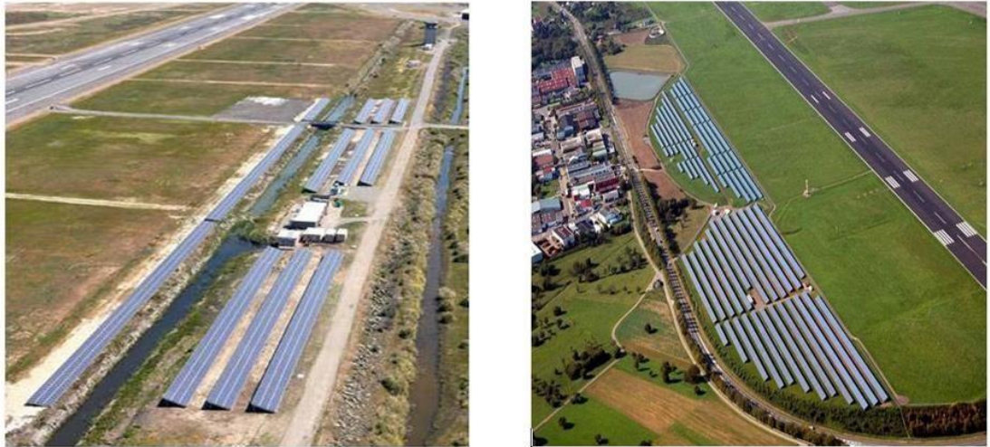
Figura 19 – Esempi di impianti fotovoltaici in ambito aeroportuale. La disposizione dei moduli fotovoltaici in prossimità delle piste di atterraggio/decollo non rappresenta un rischio per la sicurezza
