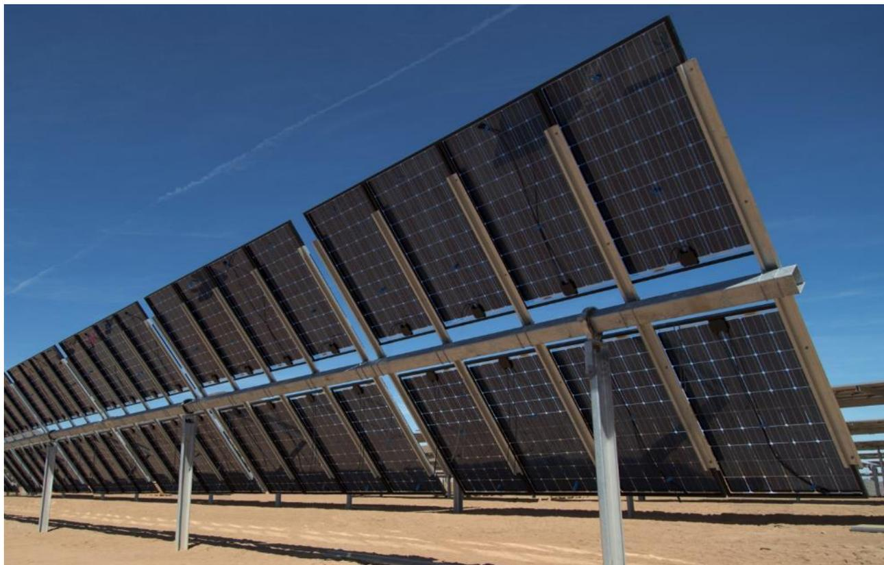
**Figura 6-4: Esempio struttura e modulo FV bifacciale**
