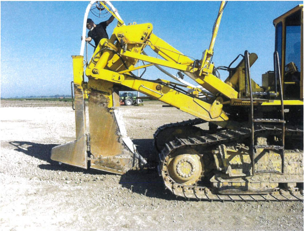
Figura 3-4 Posa del drenó
