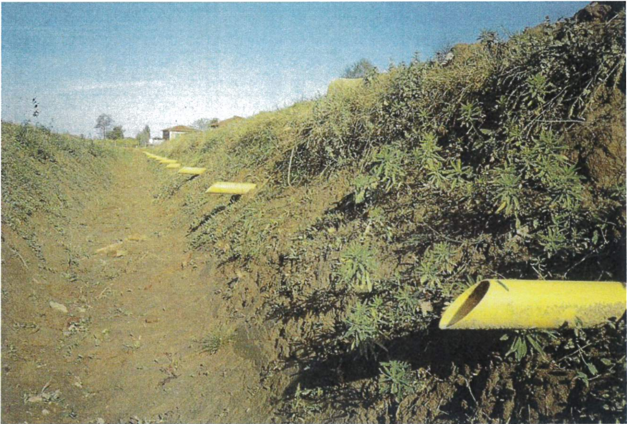
Figura 3-2 Esempio dei terminali di raccolta posati in terra
