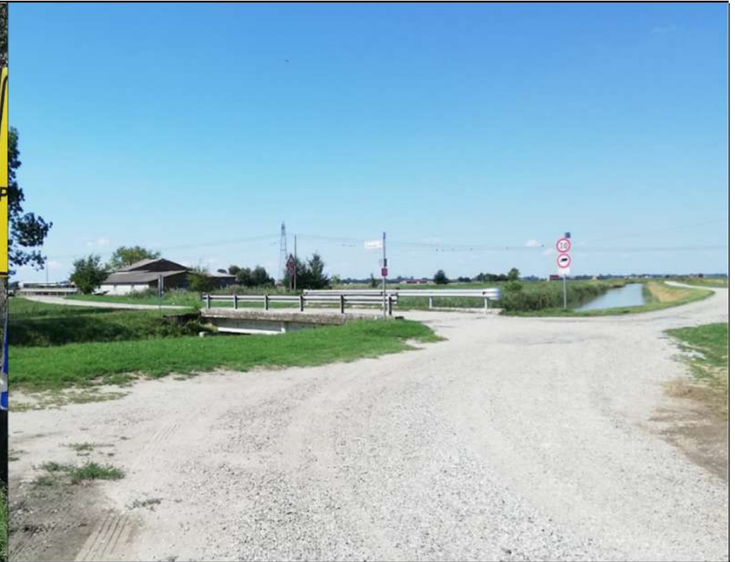
Curva in prossimità della strada di accesso
