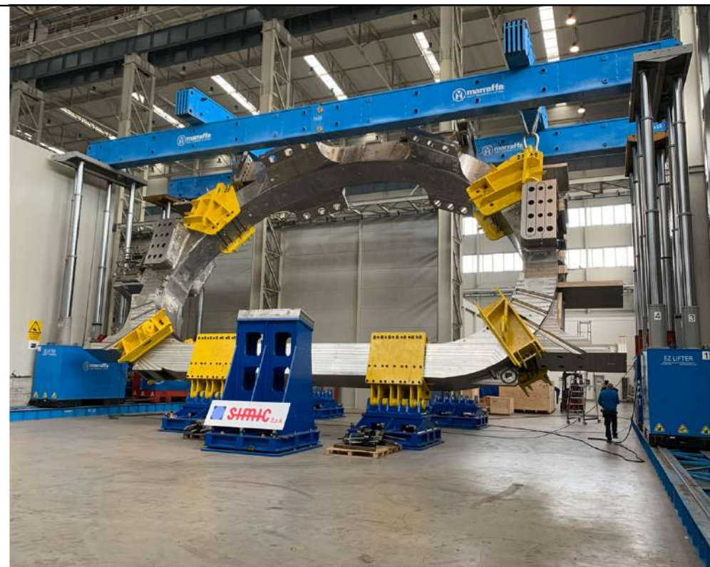
Gantry Crane in fase di movimentazione
