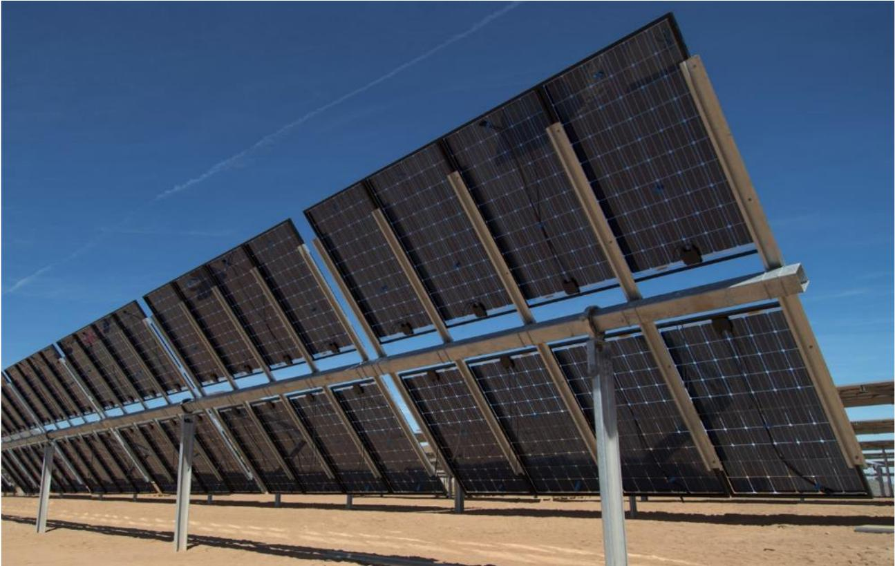
**Figura 85: Esempio struttura e modulo FV bifacciale**
